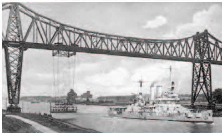
Figura 1.2. Puente de acero 2
