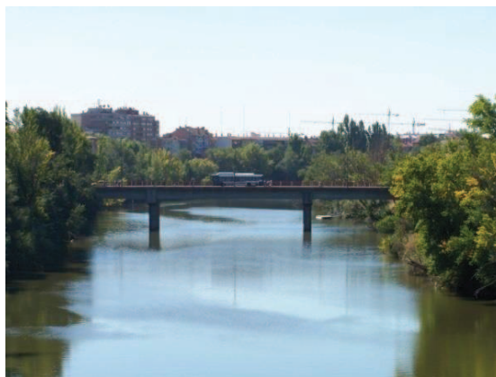
Figura 2.7. Puente viga sobre el río Pisuerga.
