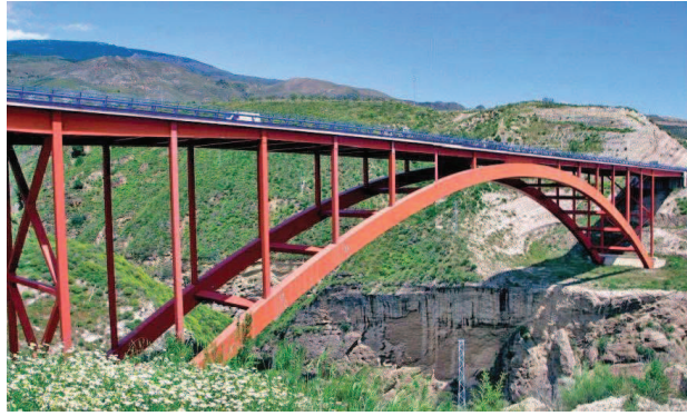
Figura 2.6. Puente de Tablate
