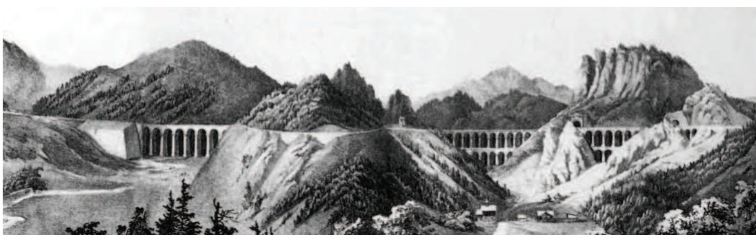
Figura 1.1. Puente de piedra 1
