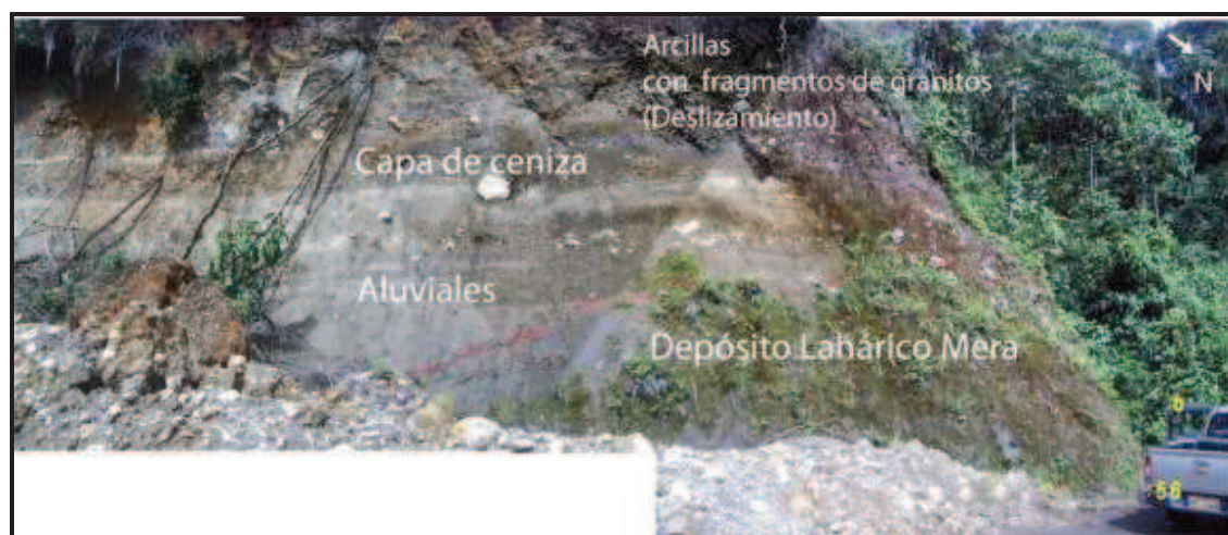
Figura 4.8. Zona de Cumanda, nueva vía entre Cumanda y Palora (UTM 0819367mE/9837769mN). Afloramiento del lahar Mera de un espesor de 5 m de altura sobre granito y debajo de depósitos aluviales. Zona de alteración.
