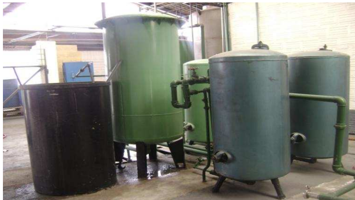
Fig. 3.10.- Filtro de Graba con Carbón Activado
