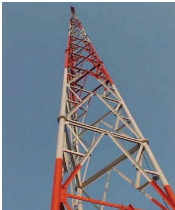
Figura 5.8: Pintura según Normativa ICAO 103
