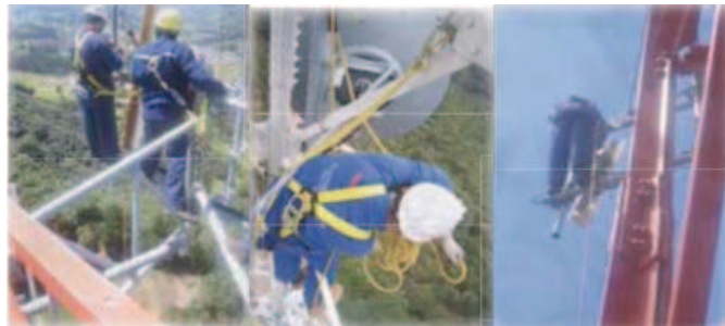
Figura 5.18: Personal realizando las diferentes operaciones en torres
