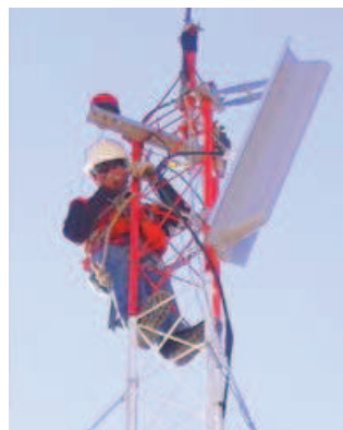
Figura 5.19: Personal instalando antena
