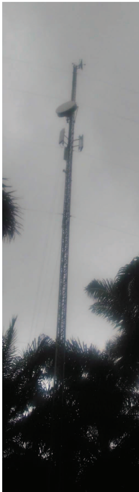
Figura 3. 6: Torre atirantada seleccionada 77
