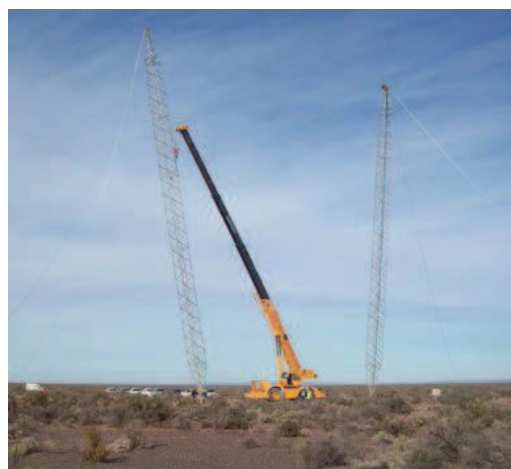
Figura 5.11: Montaje con grúa en terreno plano
