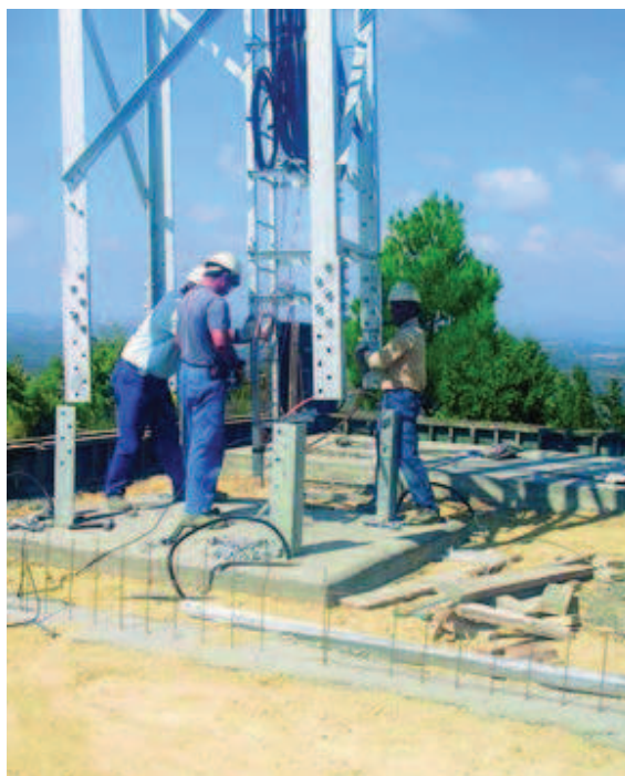
Figura 5.9: Montaje de estructuras tipo torre 104
