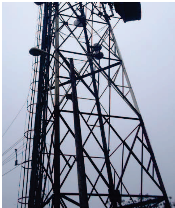
Figura 1.11: Torre autosoportada angular 11
