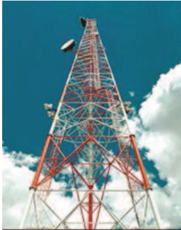
Figura 1.12: Torre autoportada tubular 12
