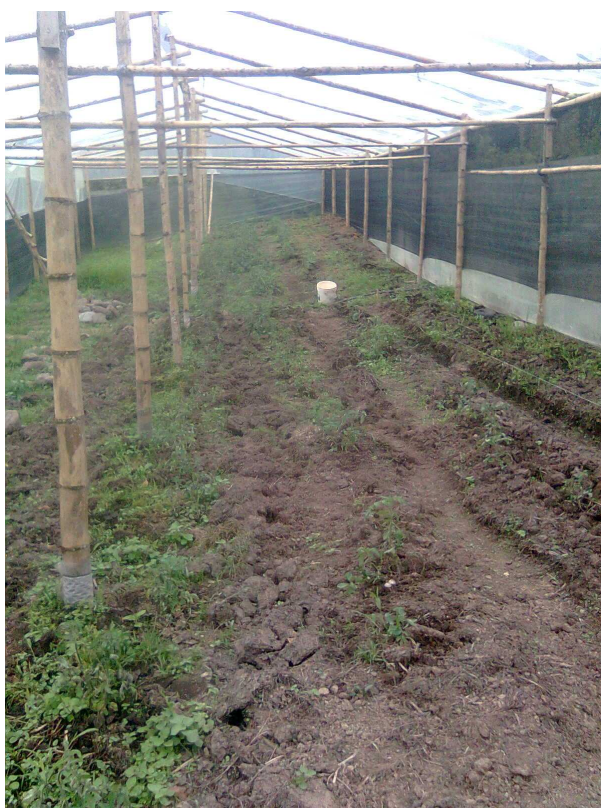
Figura 5.1 Proceso de Construcción de Invernadero y Preparación del Suelo
