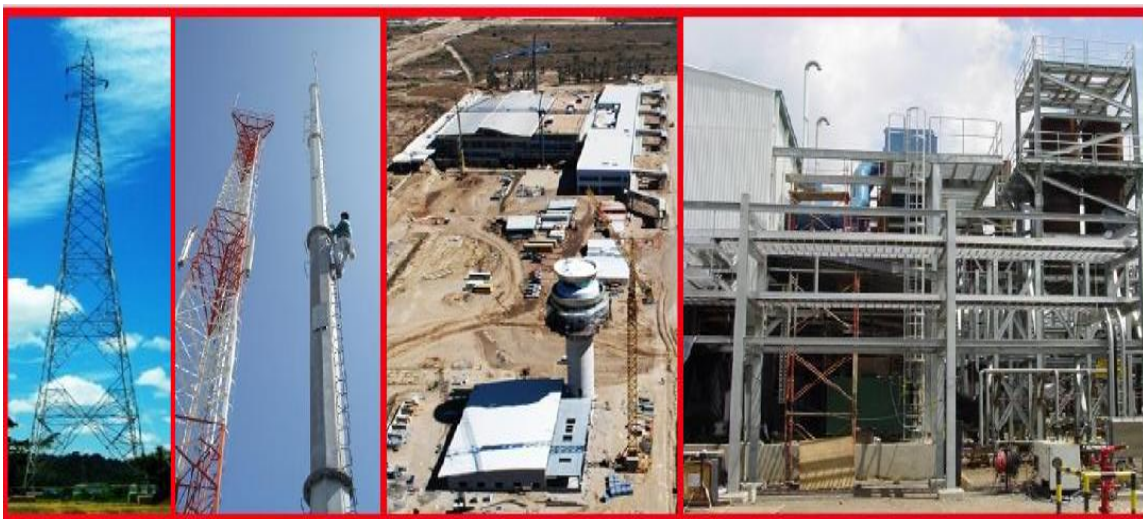
Figura 2.7 – Vista de montajes electromecánicos ejecutados (Sedemi S.C.C., 2012)
