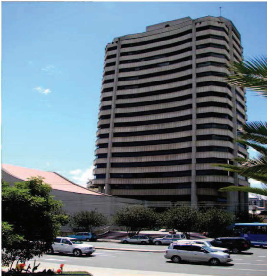
Figura 1.1 - Edificio del MTOP, Quito Fuente: (MTOP, 2012)
