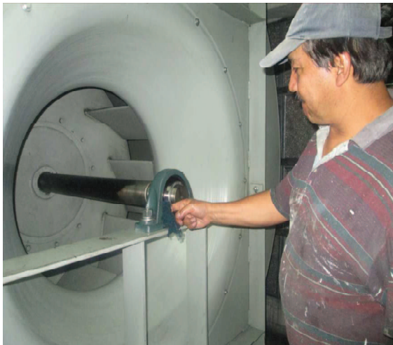
Figura 3.3- Foto descriptiva engrasado rodamientos ventiladores
