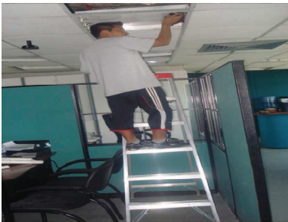
Figura 3.12- Foto descriptiva limpieza de luminarias Fuente: (Edificio MTOP, 2013)
