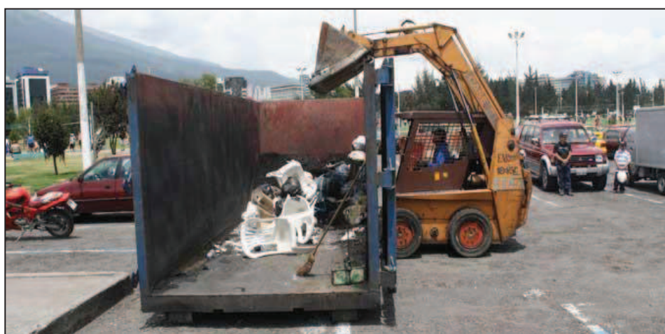
Figura 17 - Recolección de Residuos Voluminosos y Escombros
