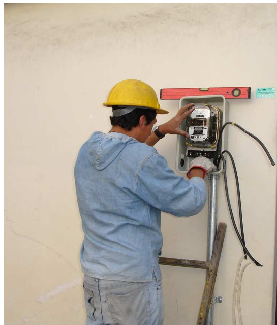
Gráfico 1.7 Instalación de la acometida
