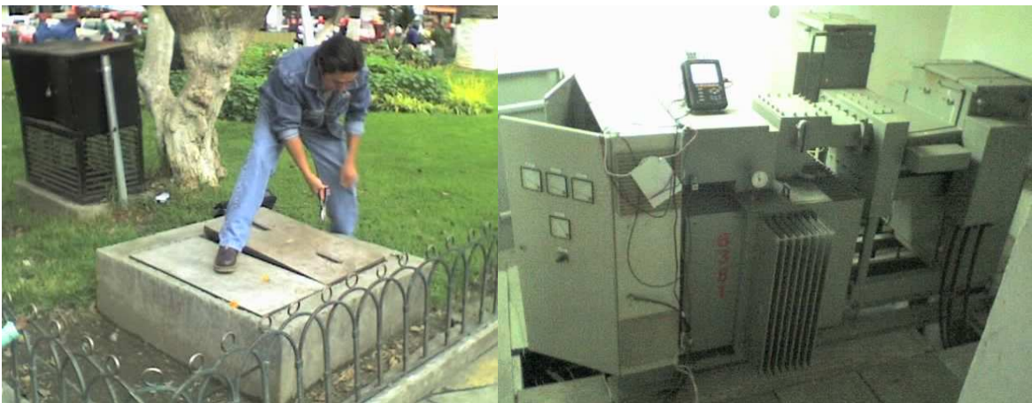
Gráfico 1.4 Ingreso Cámara Subterránea
