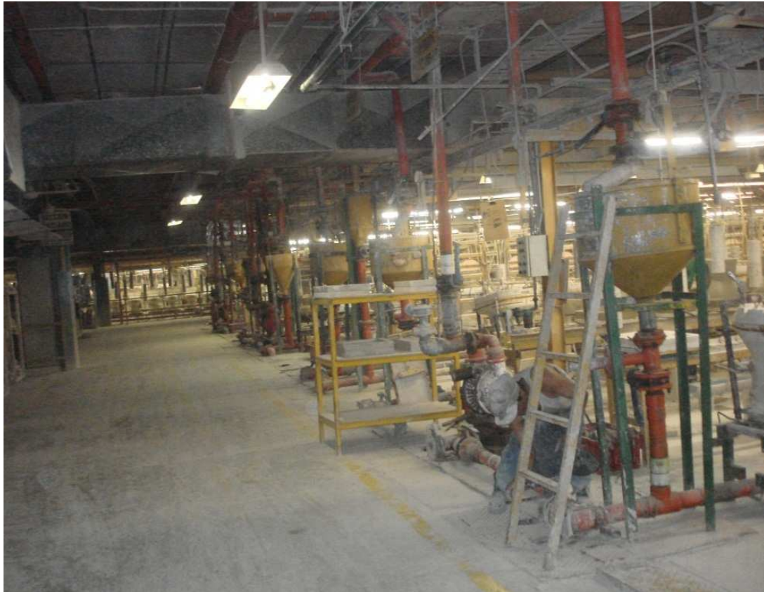
Figura 3.2. Fotografía que muestra la canaleta aérea por donde se conduce el aire caliente al área de vaciado (EDESA, 2011)
