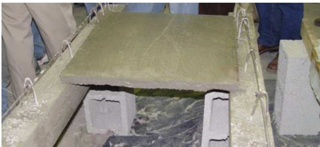
FOTO 5.1 MONTAJE DE VIGUETAS Y DOMO, S. DOMOZED. TALLER CYTED, EPN
