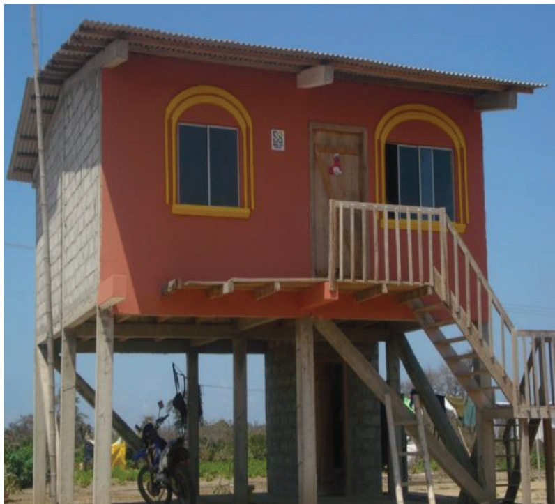
FOTO 3.1 VIVIENDA 6 X 6 ELEVADA, PUERTO LA BOCA, MANABÍ
