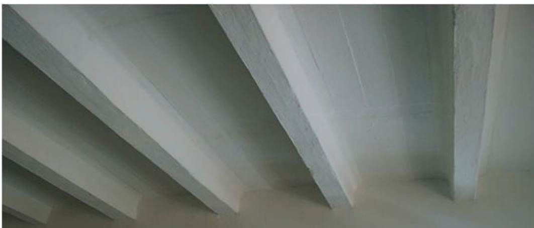
FOTO 5.12 VISTA INTERIOR DE UN TECHO CON EL SISTEMA LOSA CANAL
