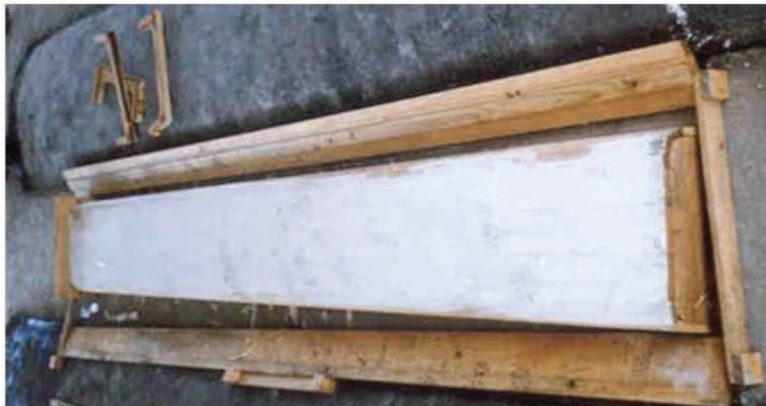
FOTO 5.10 MOLDE PARA LA FABRICACIÓN DEL COMPONENTE LOSA CANAL
