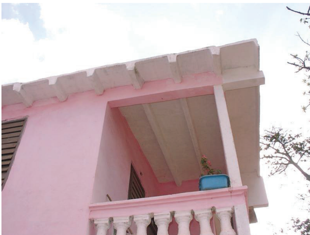
FOTO 5.13 VIVIENDA TERMINADA SISTEMA LOSA CANAL
