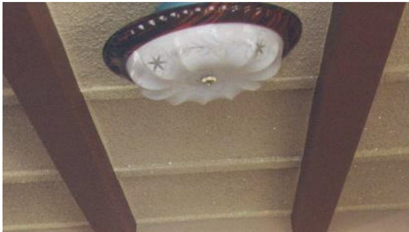
FOTO 5.2 LOSA DOMOZED TERMINADA
