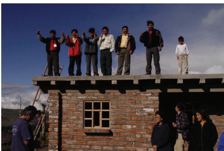
FOTO 5.3 LOSA DOMOZED EN VIVIENDA PROTOTIPO
