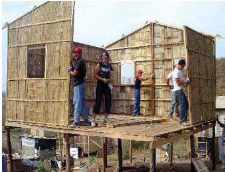
FOTO 2.5 MONTAJE VIVIENDA HOGAR DE CRISTO DE CAÑA Y MADERA
