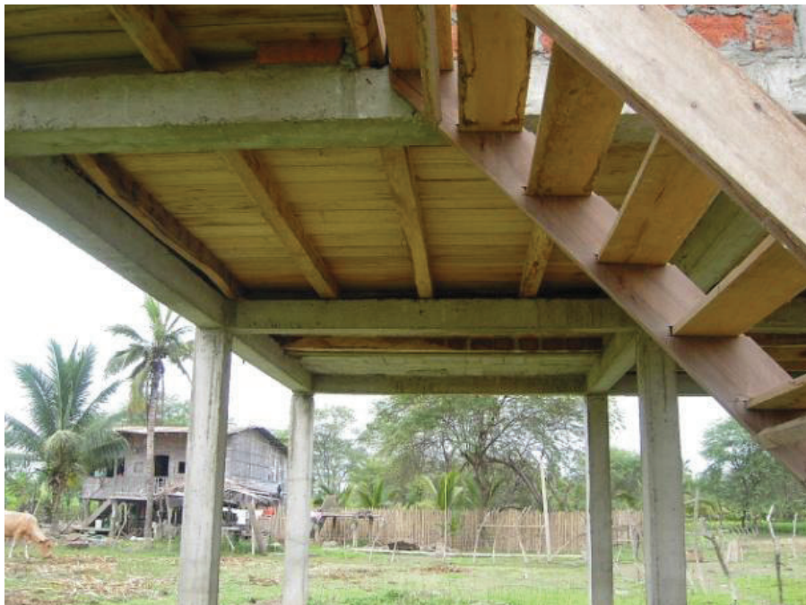
FOTO 2.2 ENTREPISO, VIVIENDA MIDUVI 6 X 6 ELEVADA
