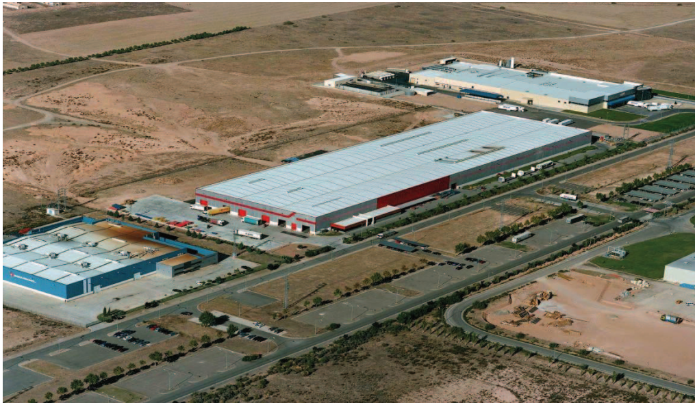
Figura 30 – Fotomontaje de las Nuevas Instalaciones de Storage System Fuente: Elaborado por el autor
