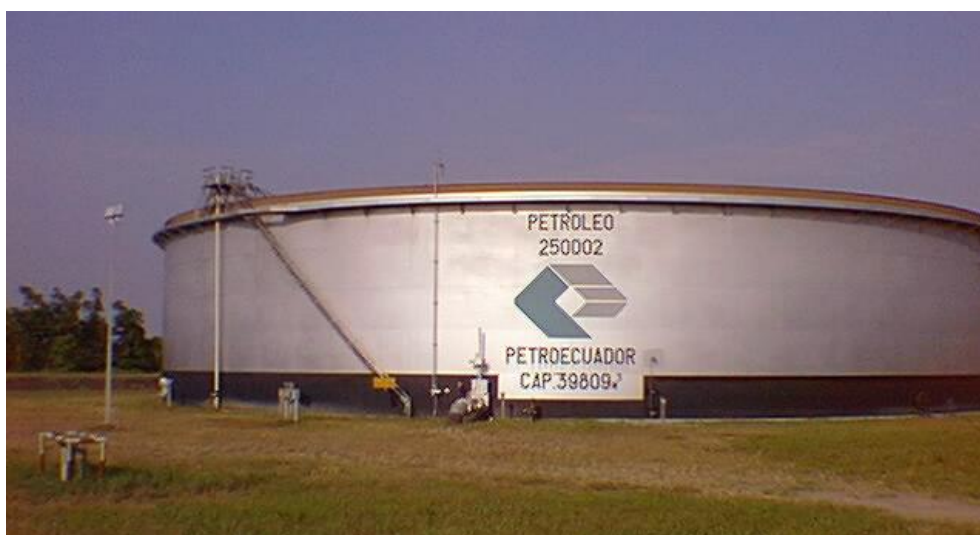
Figura No. 3 Tanque de Lago Agrio
