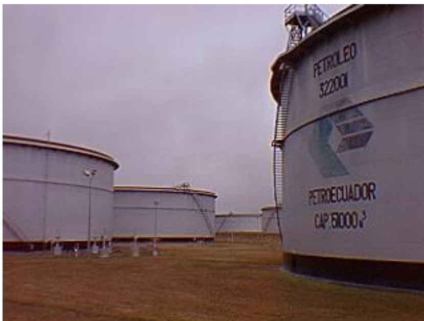
Figura No. 4 Tanques del TMB
