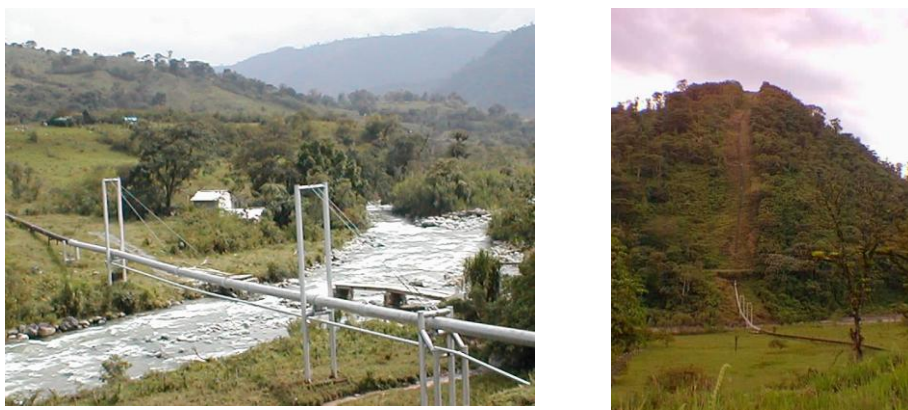
Figura No. 14 Fotografías de la tubería del Oleoducto Transecuatoriano
