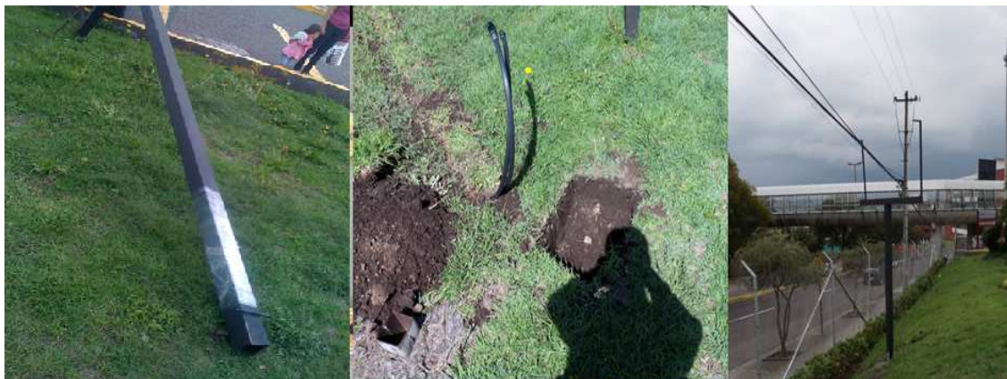
Fig. 3. 36 Montaje de la estructura metálica para soporte del panel.
