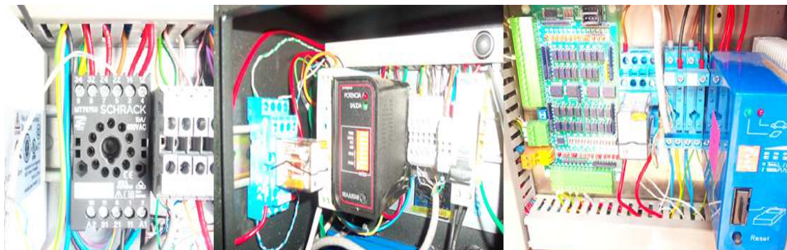
Fig. 3. 42 Relé Finder acoplado al Detector Magnético
