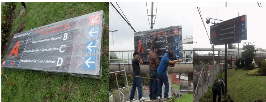
Fig. 3.37 Montaje del Panel Informativo
