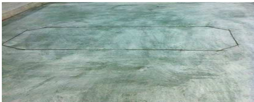
Fig. 3. 40 Sensor de Piso (Loop)
