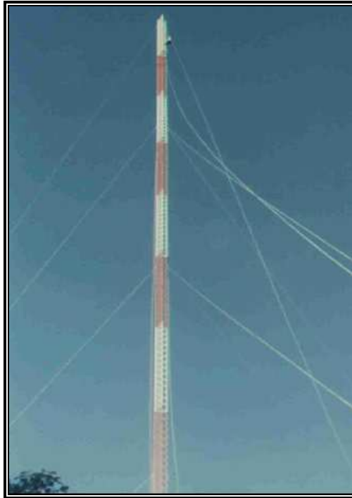
Fig. 3.1 Vista de una torre venteadada
