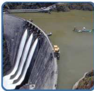
Figura 2.1- Instalaciones de HIDROPAUTE S.A.
