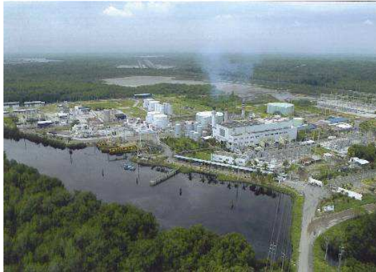
Figura 2.5- Instalaciones de ELECTROGUAYAS S.A.
