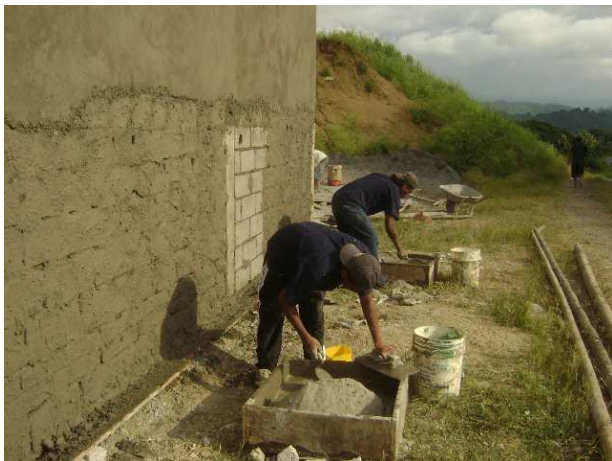
Figura 12. Trabajos de obra civil (enlucido vertical exterior)
