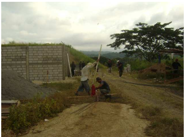
Figura 13. Corte y figurado para armadura de refuerzo de viga T de amarre superior en cerramiento.
