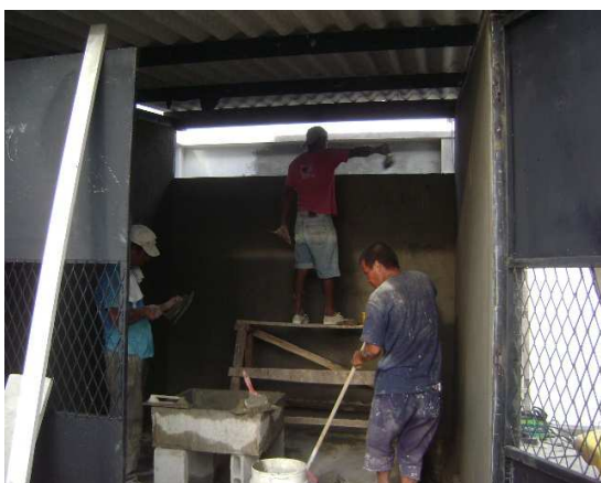
Figura 16. Construcción del cuarto para generador.
