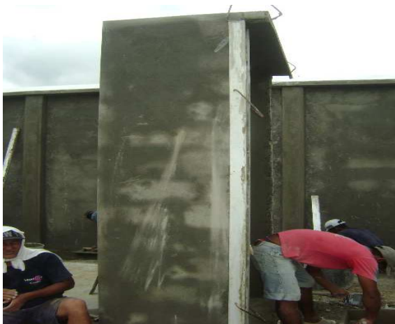
Figura 21. Construcción de nicho para sistema de control eléctrico.
