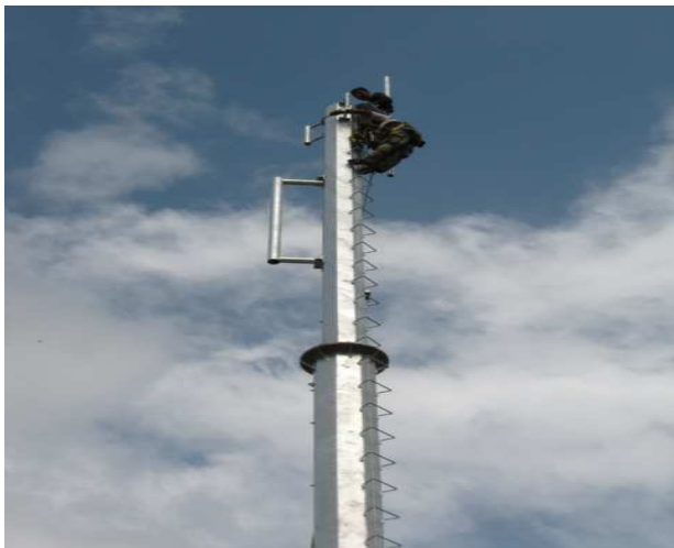
Figura 25. Verificación de orientaciones de soportes para antenas
