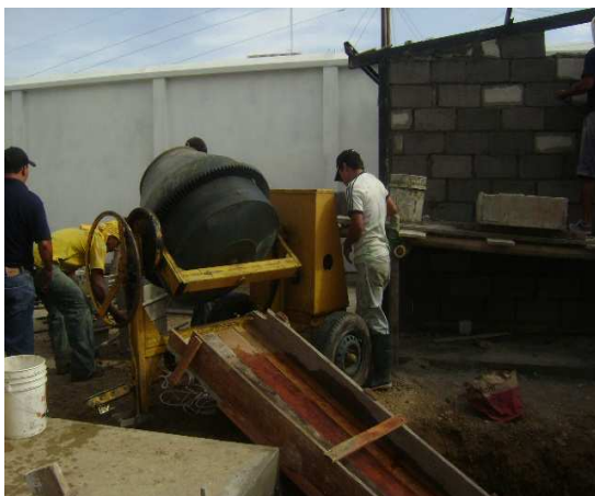
Figura 17. El concreto para la cimentación se elaboró con una dosificación de 1:2:3
