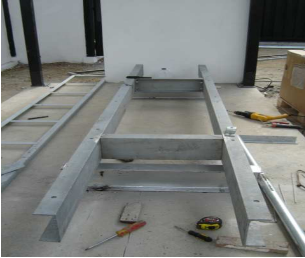
Figura 23. Instalación de base metálica para equipos concluida
