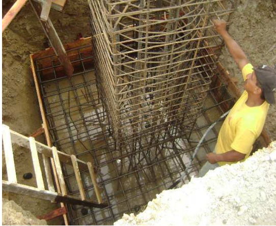
Figura 19. Fundición de la cimentación para el monopolo.
