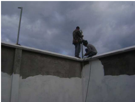
Figura 15. Enlucido, pintura y colocación de tubería galvanizada de 2" sobre cerramiento perimetral.
