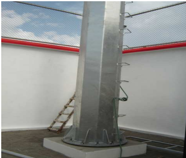
Figura 22. Montaje de de monopolo concluido
