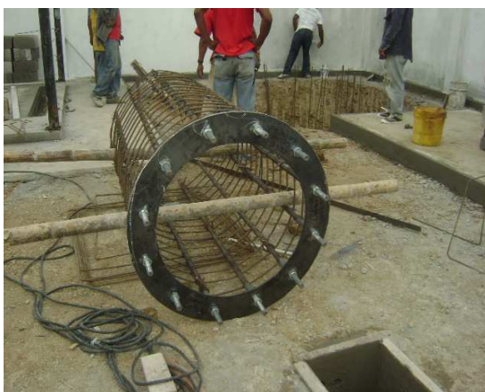
Figura 18. Elaboración del refuerzo de acero para conformar la cimentación del monopolo.
