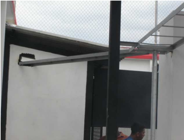
Figura 24. Adecuaciones metálicas instaladas (escalerillas, soportes)
