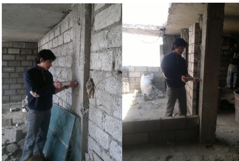
FOTOGRAFÍA 3.7.- Ensayo de columnas externas e internas para tener un mejor muestreo.
