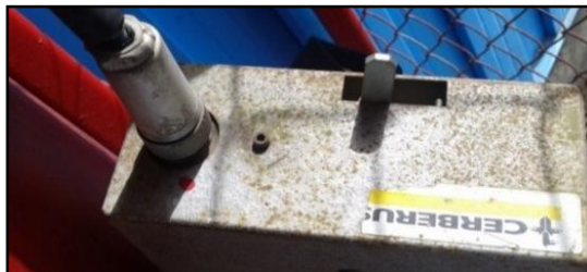
Figura 1.35 Detonador manual de la válvula de descarga
