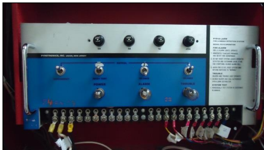
Figura 1.11 Unidad Indicadora de Fuego (FIU)
