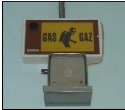
Figura 1.30 Aviso luminoso de descarga
