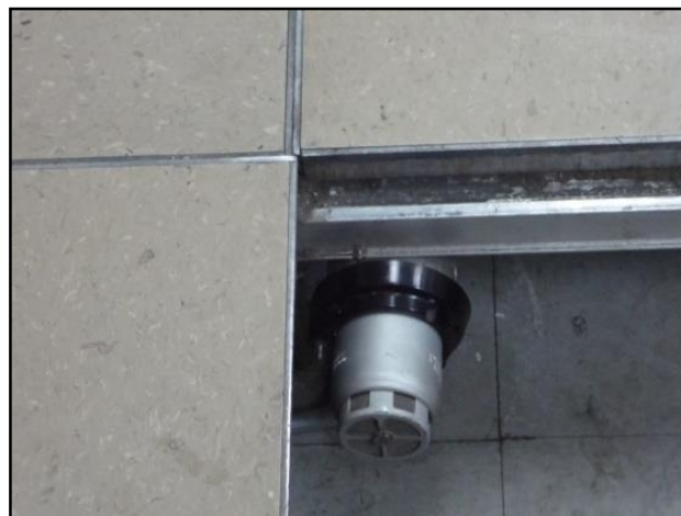
Figura 1.16 Detector de tipo ionizante instalado bajo el piso
