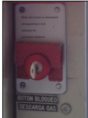
Figura 1.32 Botón Manual para bloquear la descarga
