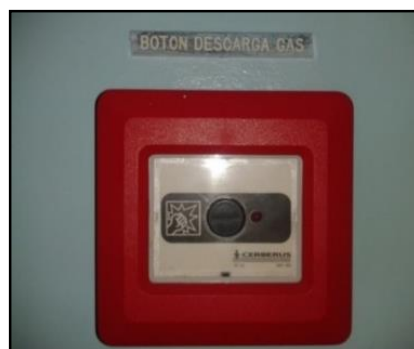
Figura 1.33 Botón de descarga de Gas
