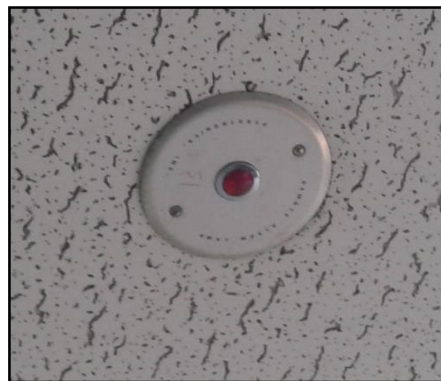
Figura 1.19 Indicador luminoso para detectores no visibles
