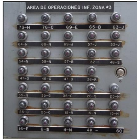
Figura 1.18 Indicadores luminosos de los detectores
