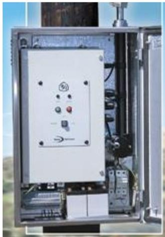
**Figura 3-8:** Control de un seccionador basado en dispositivos electrónicos.
