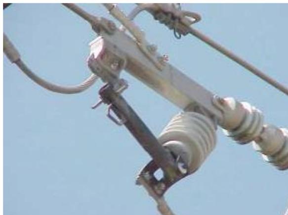
**Figura 3-6:** Seccionador [30]
