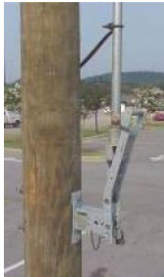
**Figura 3-4:** Control manual de un seccionador [30]
