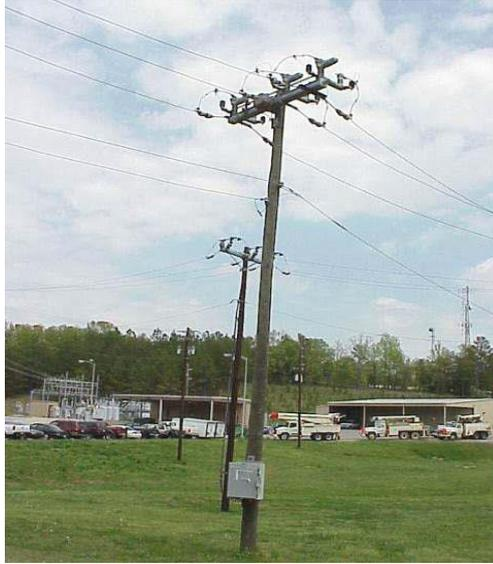
**Figura 3-7:** Seccionador operado conjuntamente con controles de motor [30]
