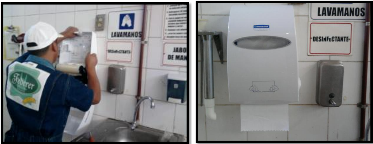
Figura 3.16. Instalación de implementos de limpieza
