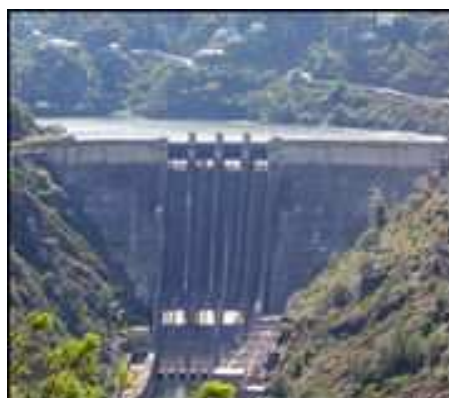
Dibujo No.2 Represa hidroeléctrica en Grandas de Salime
