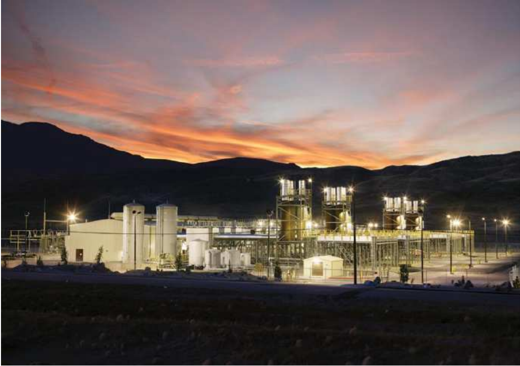
Vista Panorámica nocturna de una planta de generación de energía eléctrica Fuente: empresa en análisis Elaborado por: Juan Diego Cáceres
