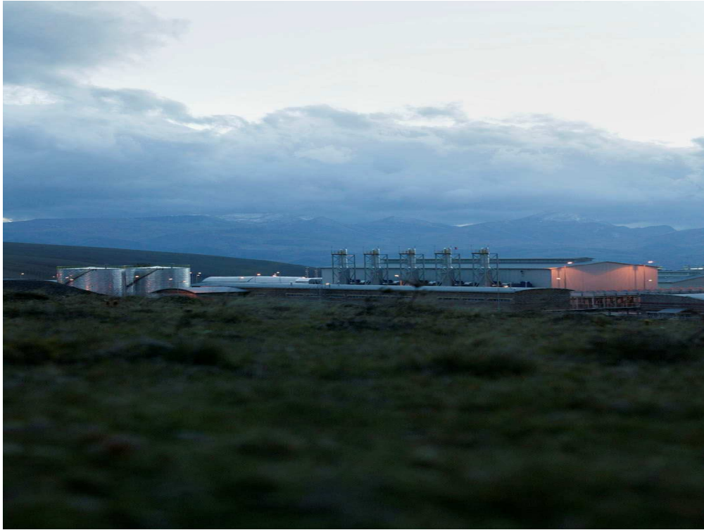
Vista Panorámica de una planta de generación de energía eléctrica Fuente: empresa en análisis Elaborado por: Juan Diego Cáceres
