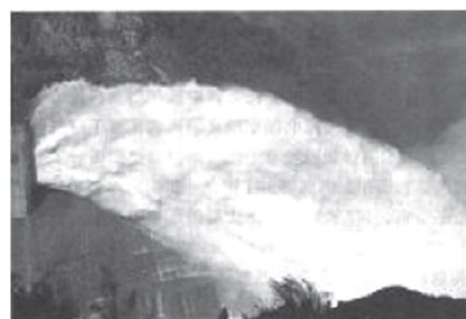
Figura 4.7: Patrón del flujo en modelo y prototipo del chorro en la salida del salto en esquí de la presa Dongjiang
