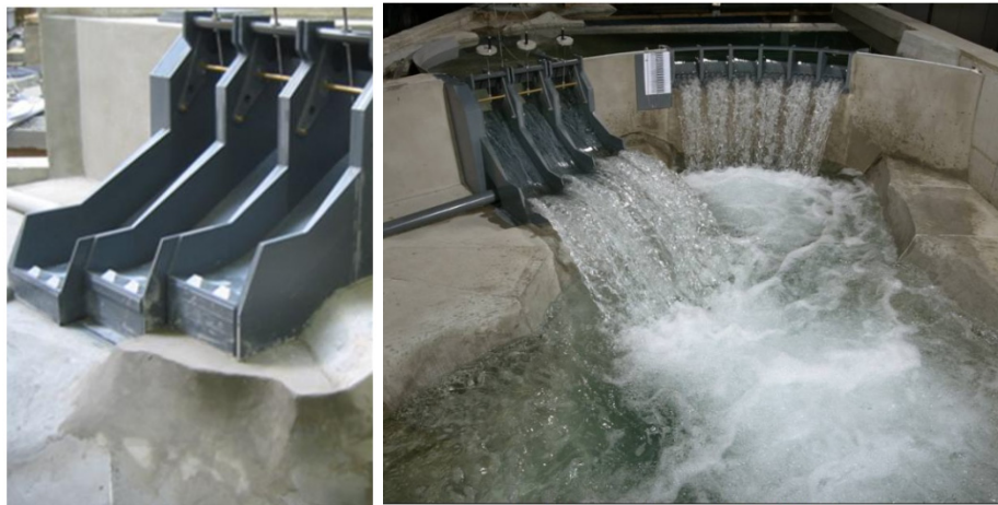
Foto 2.3: Salto en esquí con deflectores de sección transversal trapezoidal (Presa Shahryar - Irán)
