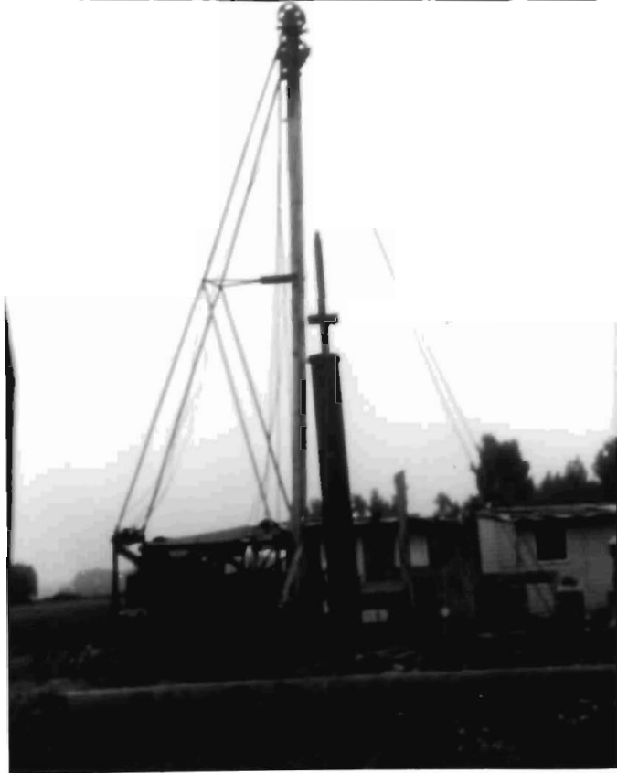
ACTIVIDAD DE LA PILOTEADORA
