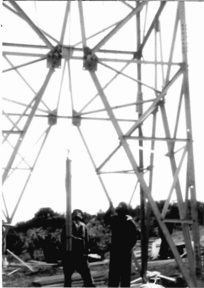
PASO DE MATERIALES
