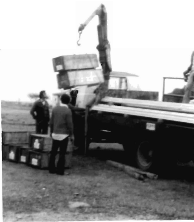
DESCARGA DE MATERIALES
