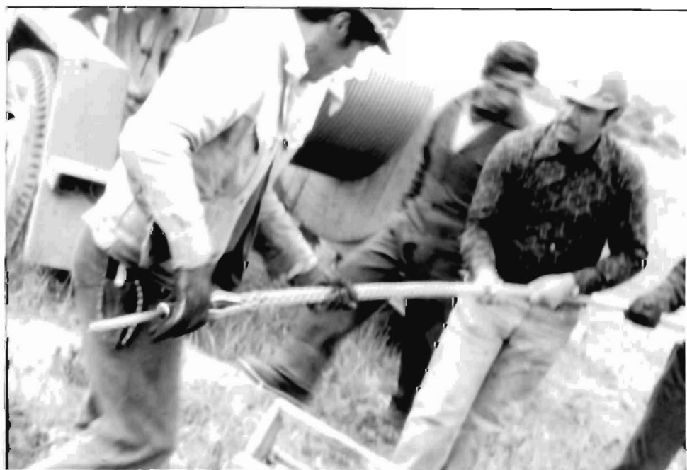
EMPALME DE CONDUCTORES
