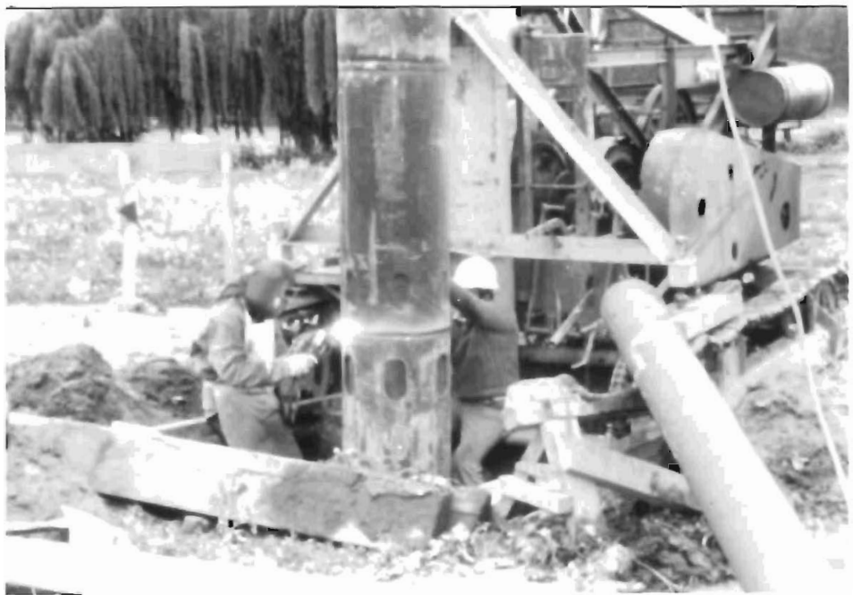
SOLDADURA EN PILOTAJE
