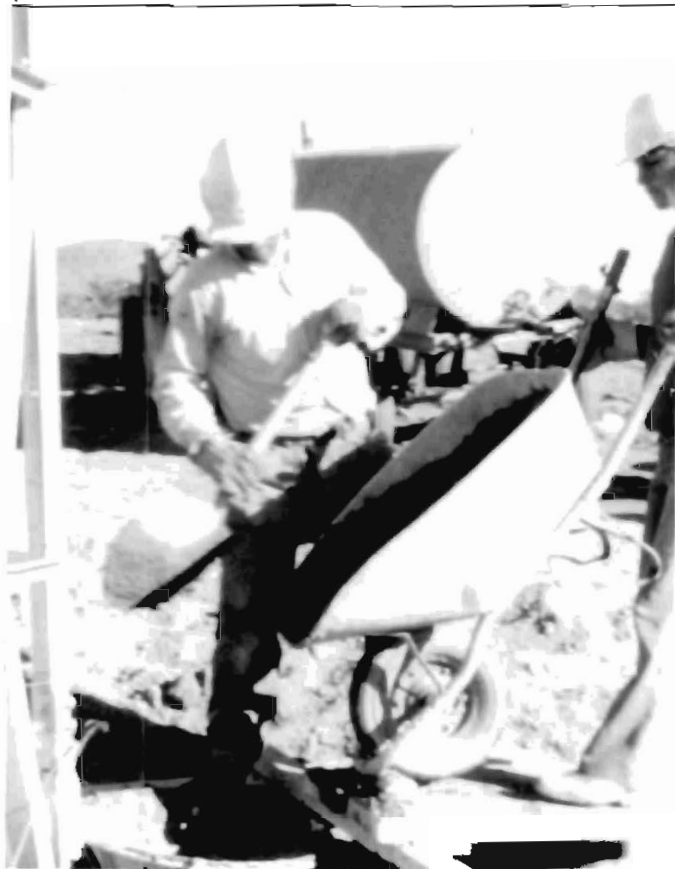
DEPOSITANDO HORMIGON
