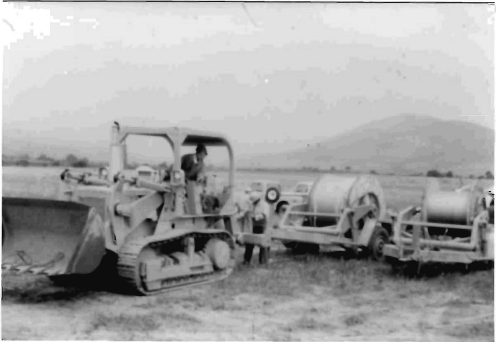
TRANSPORTE DE LOS CARRETES DE CABLES O CONDUCTORES
