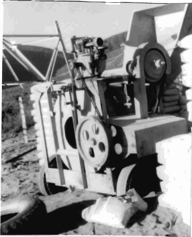
HORMIGONERA Y MATERIALES
