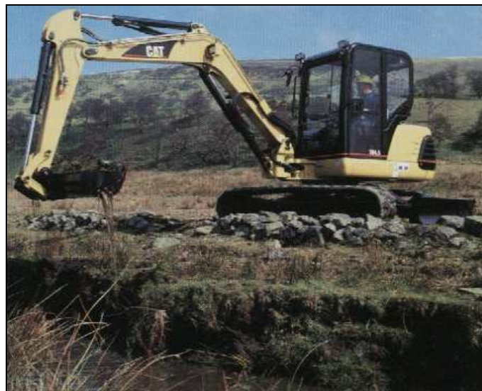
Figura 1.7 Retroexcavadora sobre orugas
