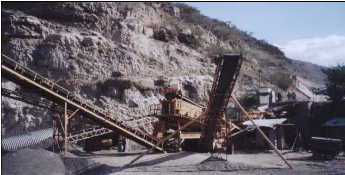
Figura 1.21 Planta Completa de Trituración
