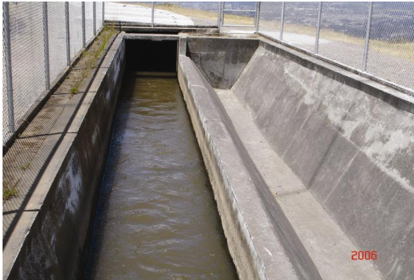
Foto: Canal de conducción agua cruda Pita-Tambo. Nótese las protecciones para evitar contaminación.
