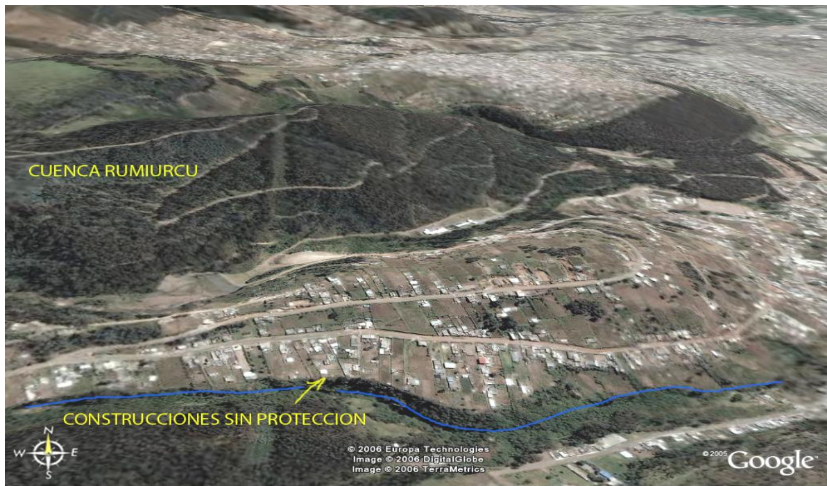
Foto Nº 3 Cuenca Rumiurcu. Nótese la pendiente y construcciones sin protección ambiental. (Fuente: Google earth)
