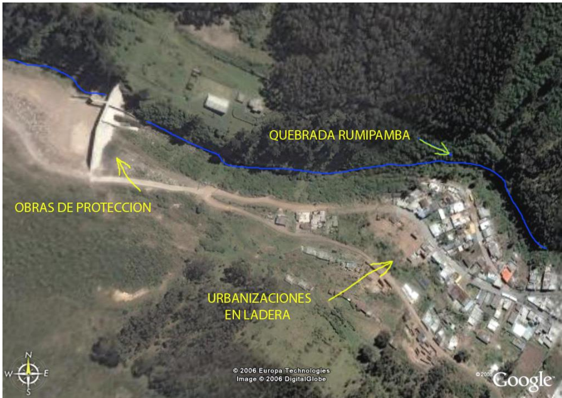
Foto N° 1 Cuenca Rumipamba (Fuente: Google earth)
