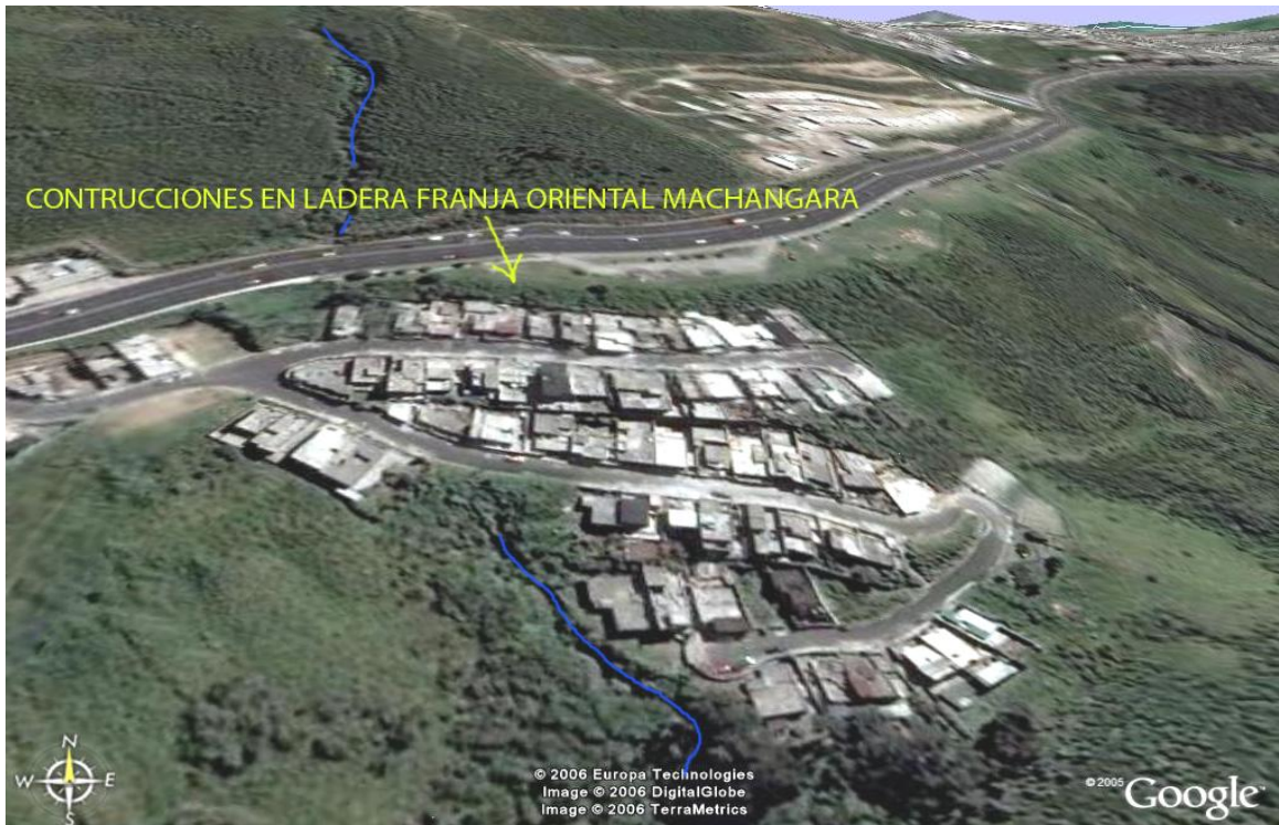
Foto Nº 5 Urbanización en ladera sector La Tola. Nótese la falta de obras de protección ambiental. Nótese el drenaje natural que acrecienta el riesgo.
