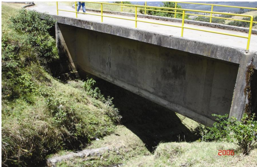
Foto: Canal de conducción agua cruda Pita-Tambo. Nótese las protecciones para evitar contaminación.
