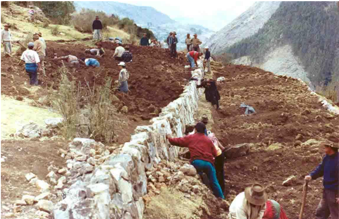
Foto Nº 0. Terraceo en ladera y protección con muros de contención. (Fuente. Wilfried Strauch 2000)
