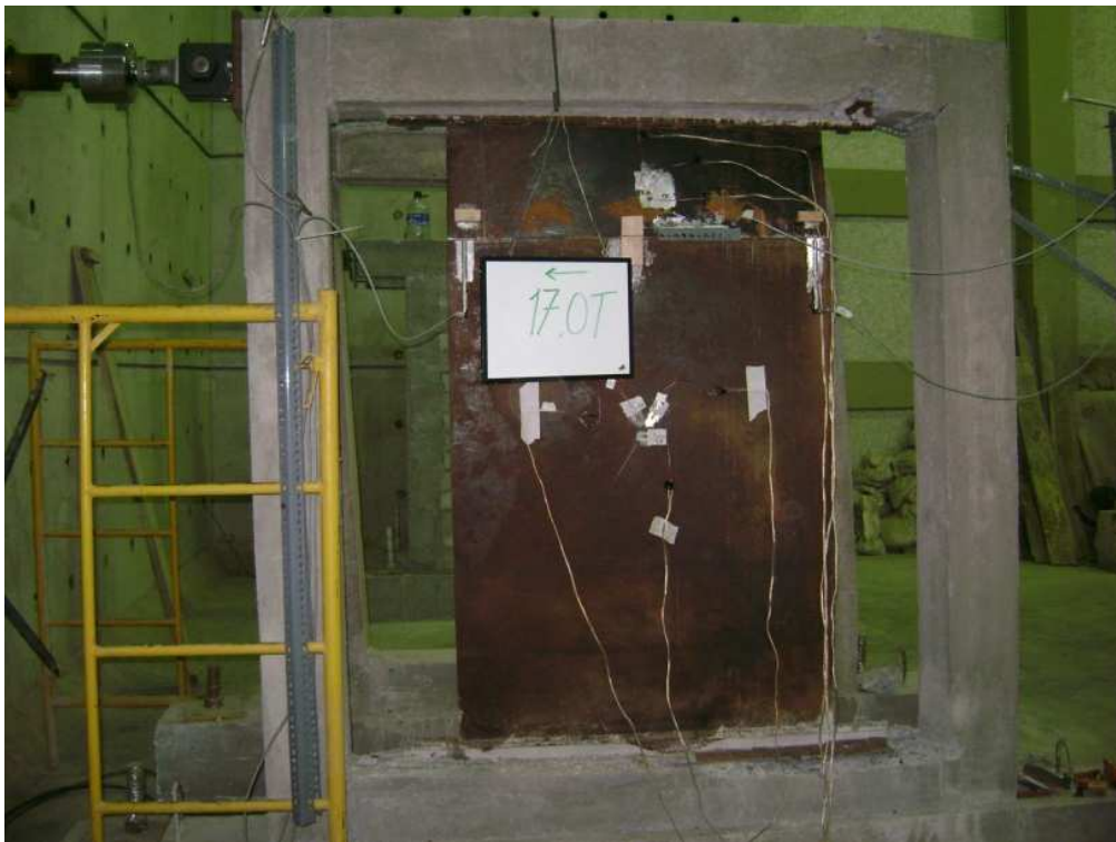
Figura 4.27o. Estado final del pórtico PVEW. Carga -17.0Ton.
