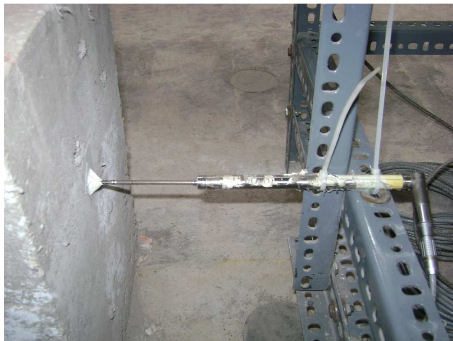
Figura 4.14c. LVDT en extremo de la viga de cimentación.
