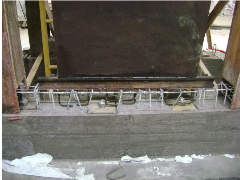
Figura 4.11a. Ensamblaje del muro viscoelástico en el pórtico PVEW en cadena inferior.
