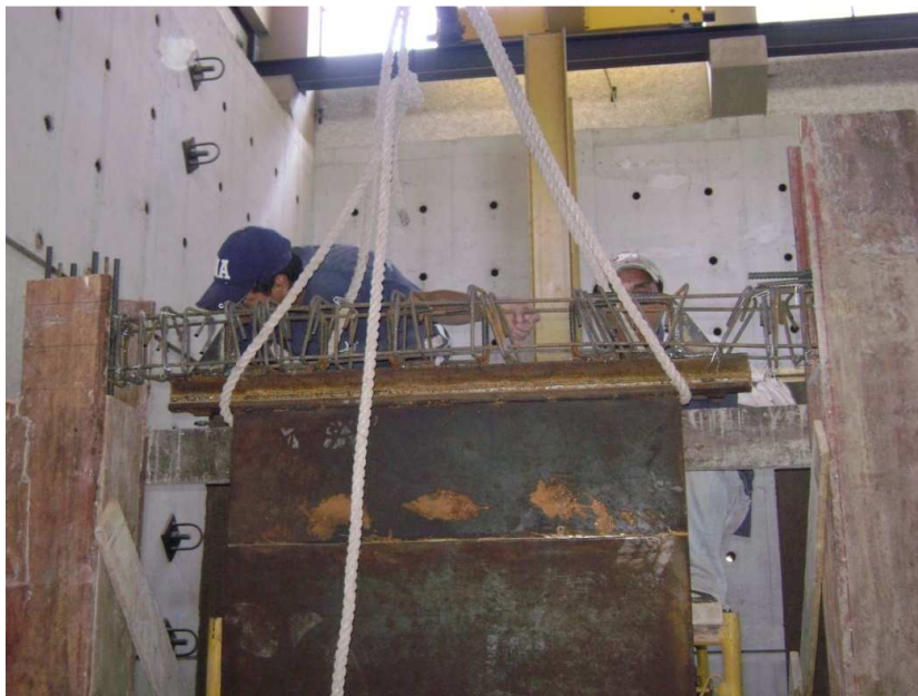
Figura 4.11b. Ensamblaje del muro viscoelástico en el pórtico PVEW en viga aérea.
