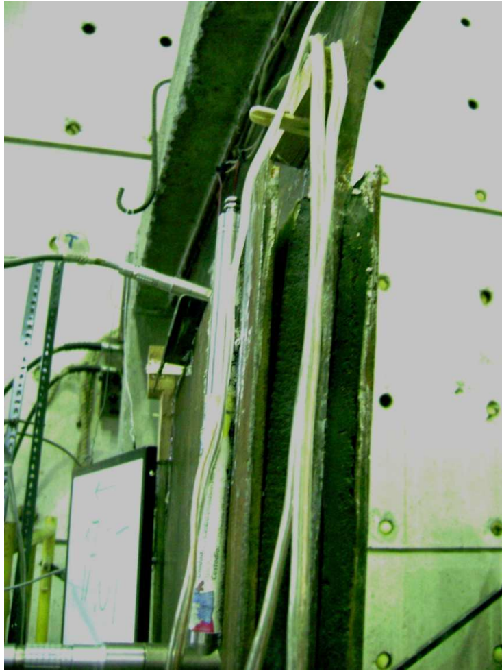
Figura 4.27k. Separación entre placas del VEW. Carga -17.0Ton.
