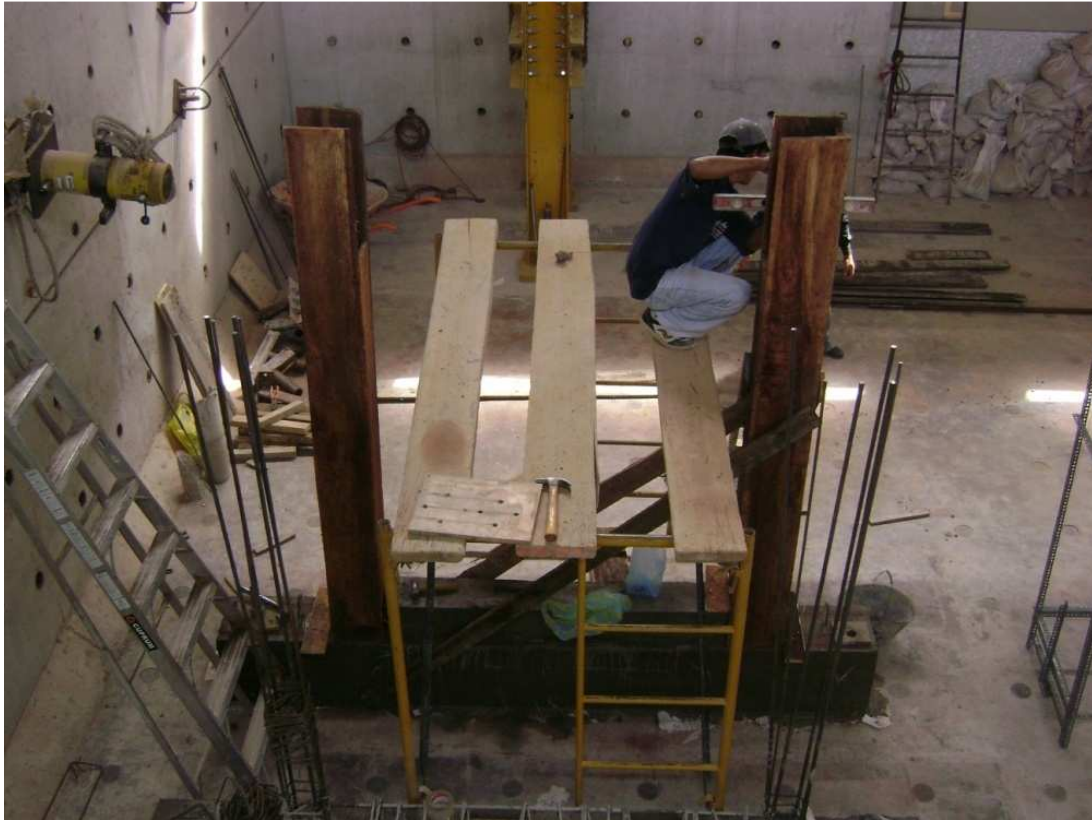
Figura 4.6b. Proceso constructivo de las columnas del PSVEW. Encofrado.
