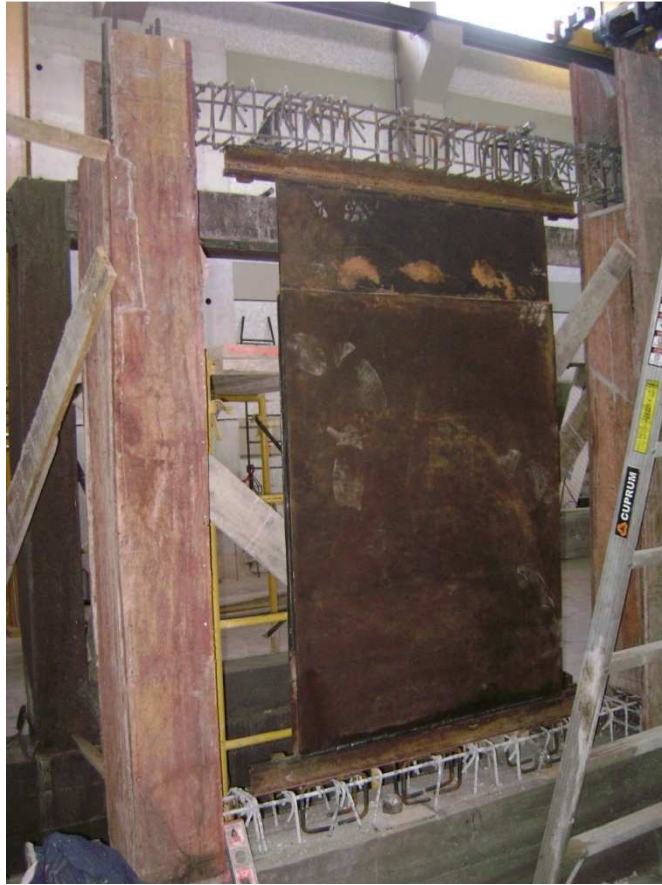
Figura 4.11c. Ensamblaje completo del muro viscoelástico en el pórtico PVEW.
