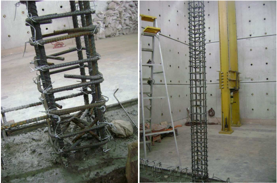
Figura 4.6a. Proceso constructivo de las columnas del PSVEW. Armado.
