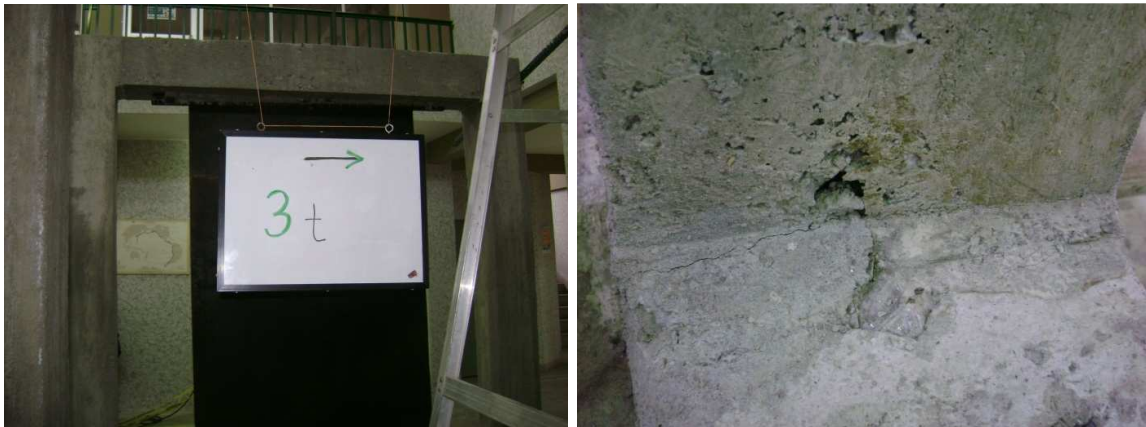
Figura 4.24b. Carga final -3.0Ton. Aparecen primeras fisuras en las uniones.
