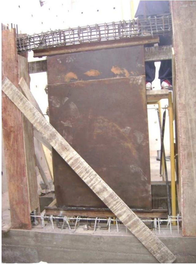
Figura 4.11e. Armado final previo proceso de fundición del PVEW.
