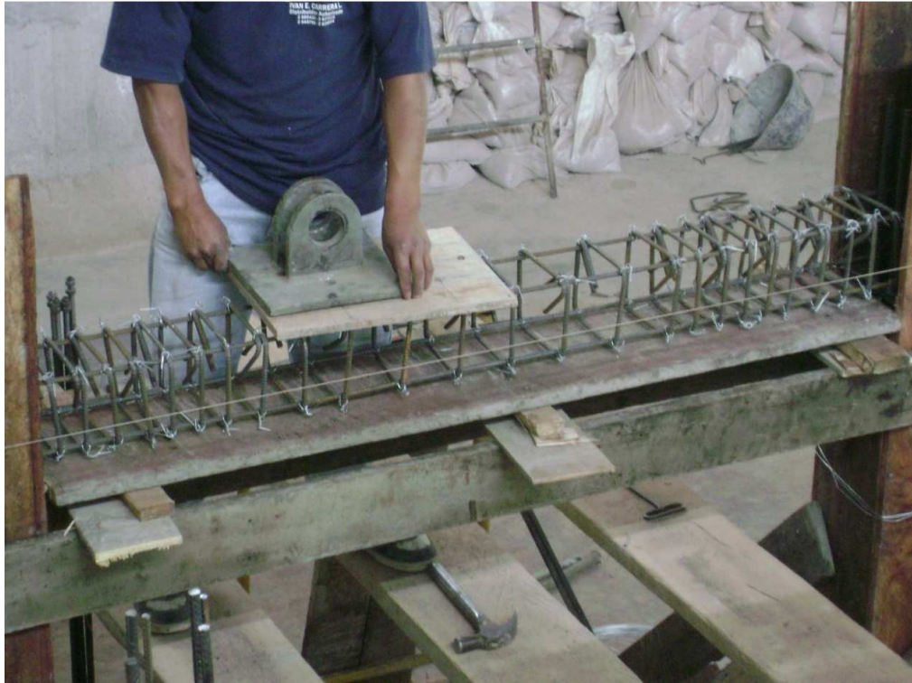
Figura 4.8a. Armado viga superior de H.A. del PSVEW. Previa ubicación de varillas para anclaje.
