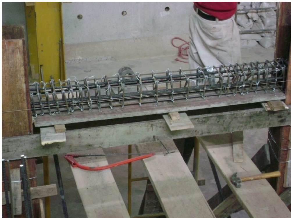
Figura 4.8b. Armado viga superior de H.A. del PSVEW. Armado completo.
