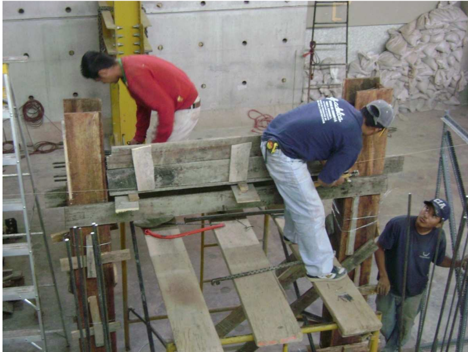
Figura 4.8c. Encofrado viga superior de H.A. del PSVEW.
