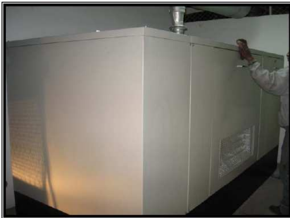
Fotografía N° 3.2. Ejemplo de cabina de isonorización a utilizarse en el generador eléctrico, Planta de Bellavista.
