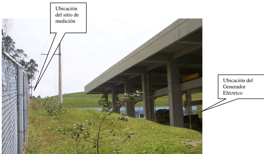
Fotografía N° 3.1. Ubicación del generador eléctrico respecto del sitio de medición , Planta de Bellavista.
