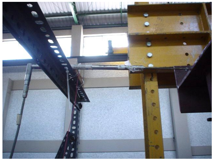
Foto 4.3.2. Ubicación LVDT tercer nivel.
