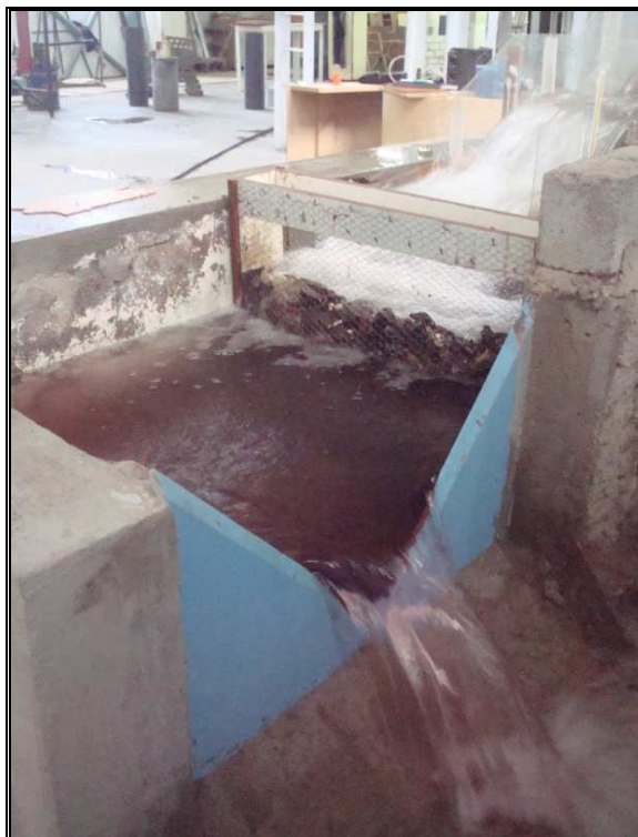
Fotografía No. 7.10: Descarga en vertedero Q_4 = 11,5 lt/s
