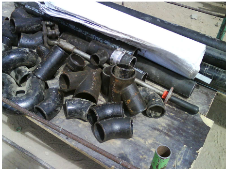
Transporte de Tubería y accesorios
