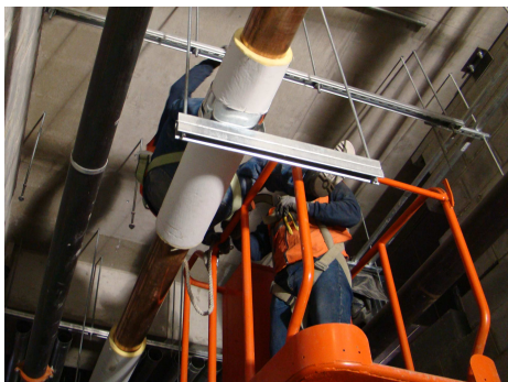
Elevación de tubería sobre el terreno
