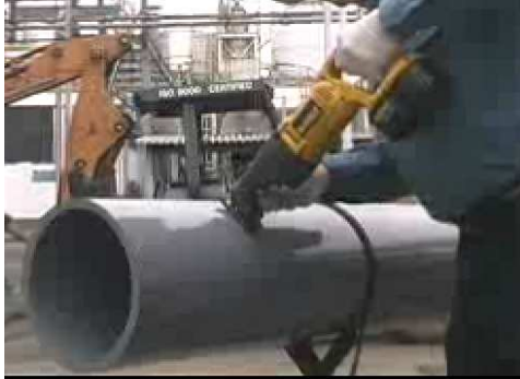
Corte de Tubería
