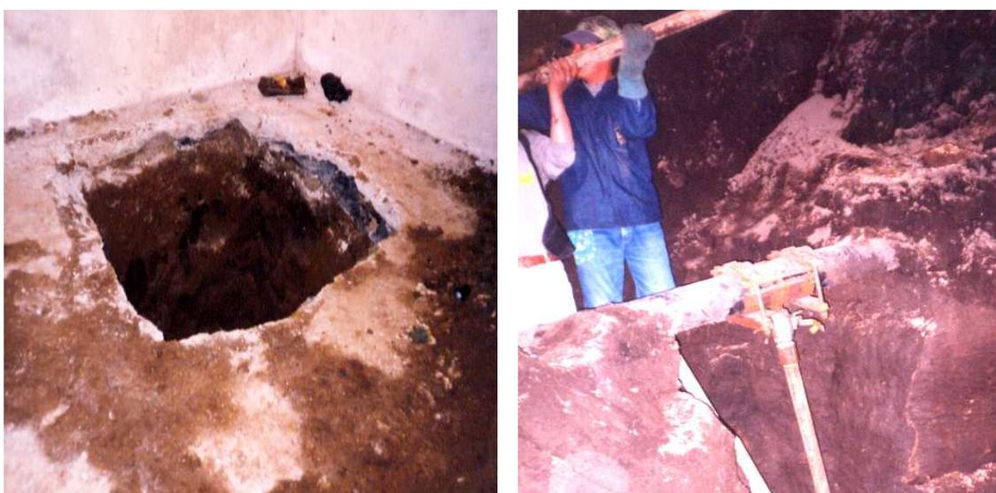
**Foto 1.2. Perforaciones clandestinas para robo de derivados** <sup>[ 1.2]</sup>
