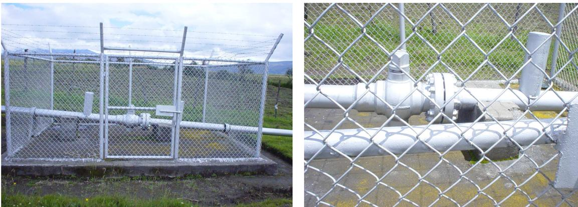
**Foto 1.3. Válvulas reductoras de presión.**
