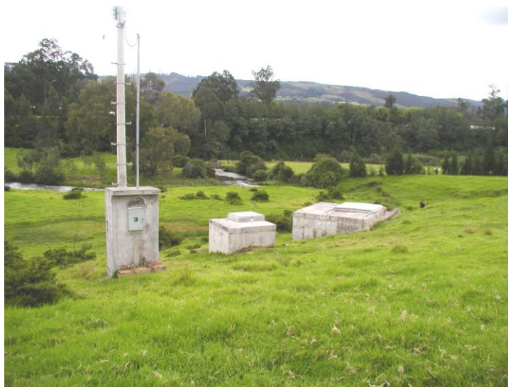
Fotografía No. 6.11: Características Físicas del Cruce en el Río San Pedro. (Sistema La Mica).
