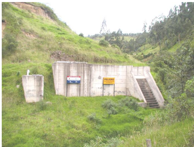
Fotografía No. 6.10: Vista general del cruce en el río Sambache (sistema La Mica).
