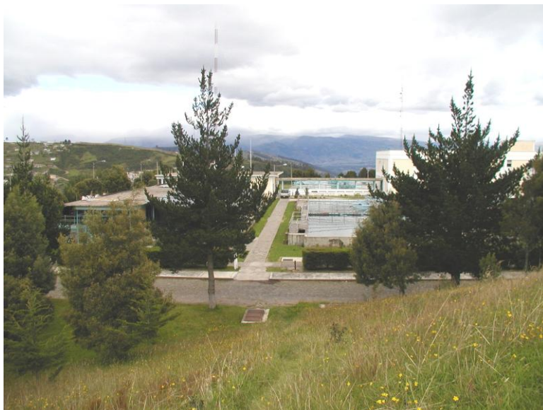
Fotografía No. 6.16: Planta de Tratamiento de Puengasí
