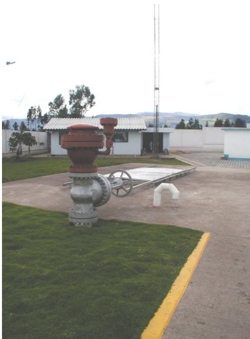
Fotografía No. 6.13: Vista general Campamento La Moca (sistema La Mica)
