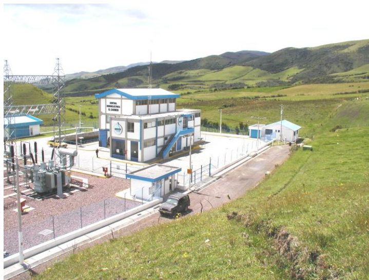
Fotografía No. 6.14: Vista de la Central Hidroeléctrica El Carmen. (Sistema La Mica)
