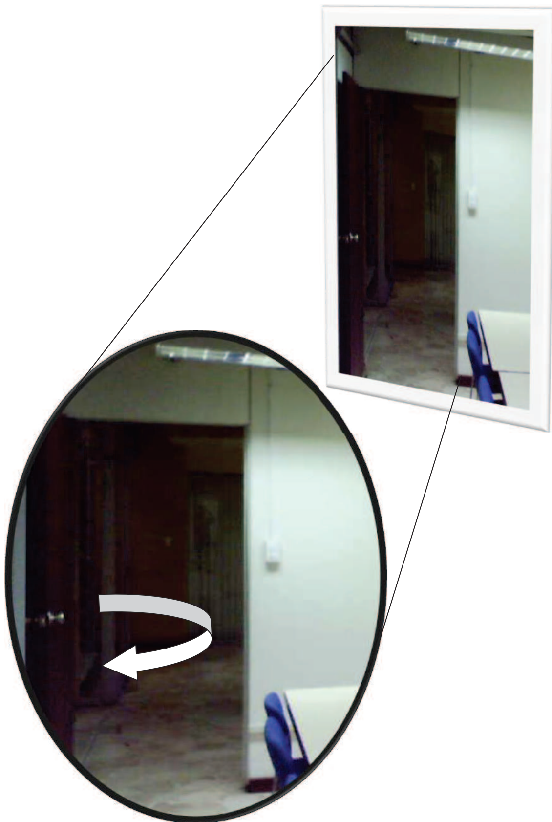
Figura A.III.15. Factores de riesgo que obstaculizan la evacuación de personas y bienes salvaguardables. Puertas abren en sentido contrario al de la evacuación.
