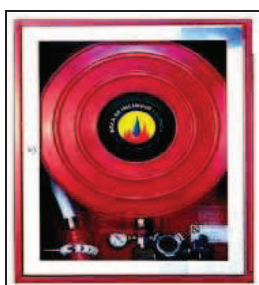
Figura 1.11. Boca de incendio equipada de 25 mm. (APCI, 2009)
