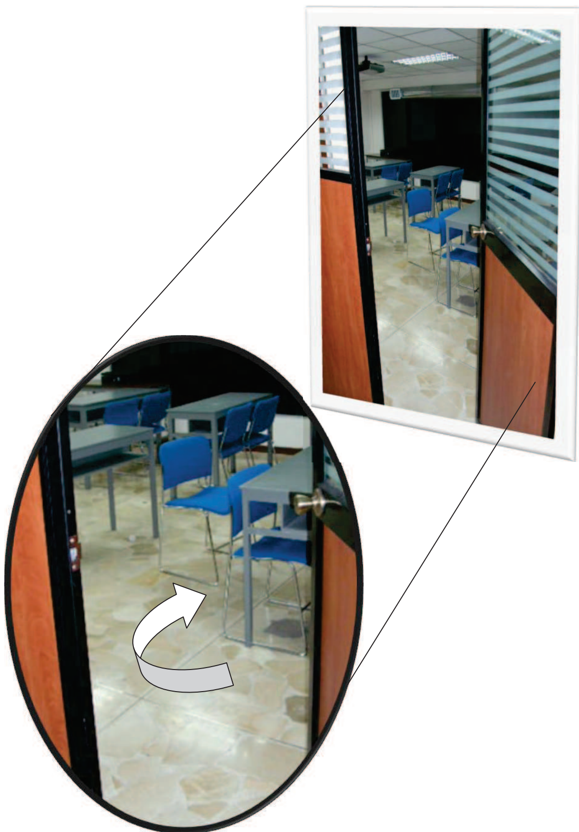
Figura A.III.16. Factores de riesgo que obstaculizan la evacuación de personas y bienes salvaguardables. Puertas abren en sentido contrario al de la evacuación.
