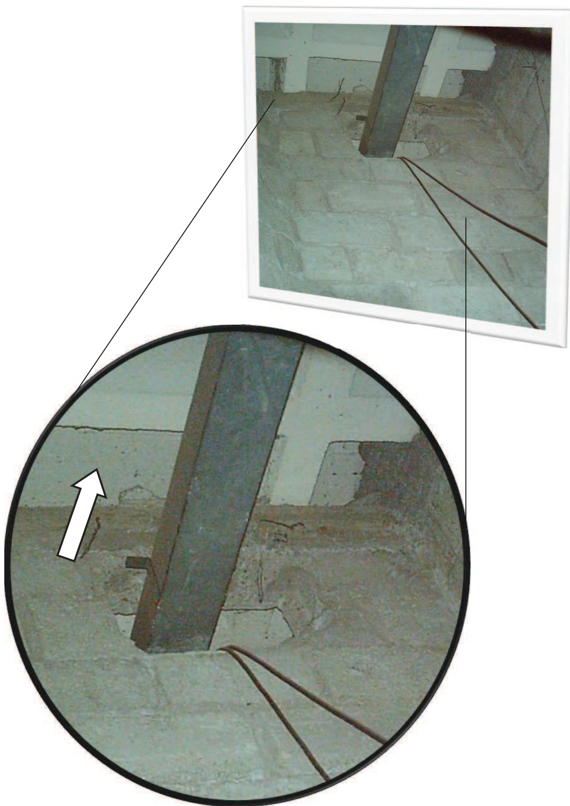
Figura A.III.5. Factores de riesgo que propician la propagación del incendio. Módulos de poliespuma: Material altamente combustible. Goteo y humos extremadamente tóxicos.
