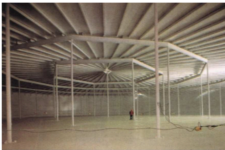
Figura 3.39 Vista interior de un tanque con techo cónico soportado por una estructura
