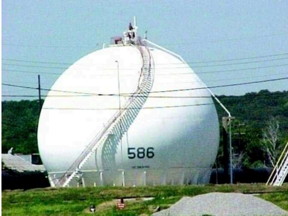
Figura 2.3 Recipiente a presión - Esferoide
