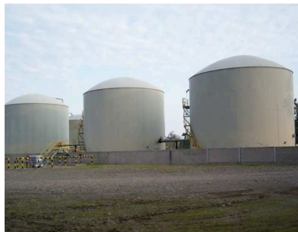
Figura 2.2 Tanques a baja presión con techos domo
