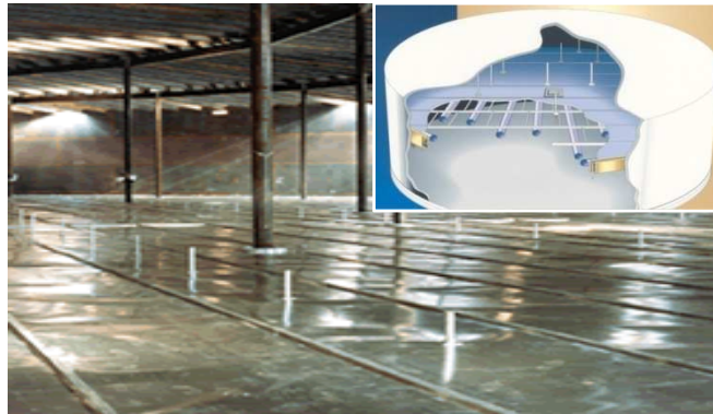
Figura 2.22 Techo flotante tipo cáscara y flotador
