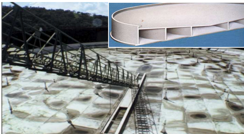
Figura 2.19 Techo flotante externo de doble membrana
