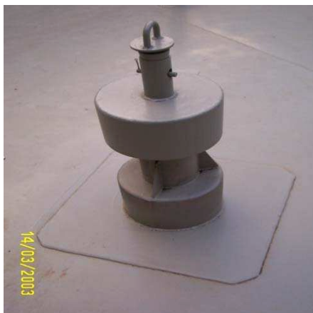
Figura 2.53 Venteo automático
