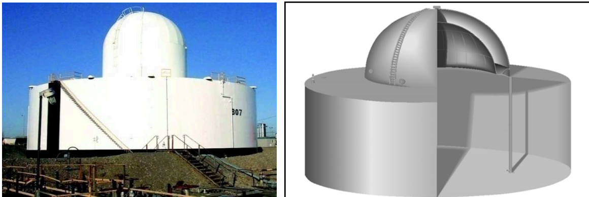
Figura 2.13 Tanque de techo cónico con domo de vapor (vapor dome roof)
