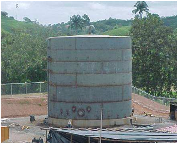
Figura 2.1 Tanque atmosférico con techo cónico
