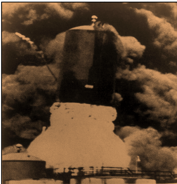
Figura 3.48 Efecto del desprendimiento del tanque de su fondo
