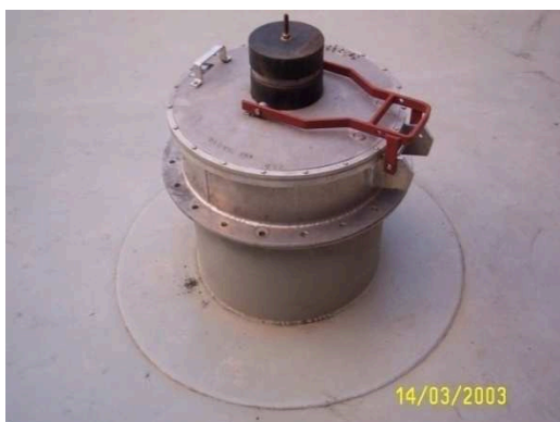
Figura 2.48 Venteo de techo flotante
