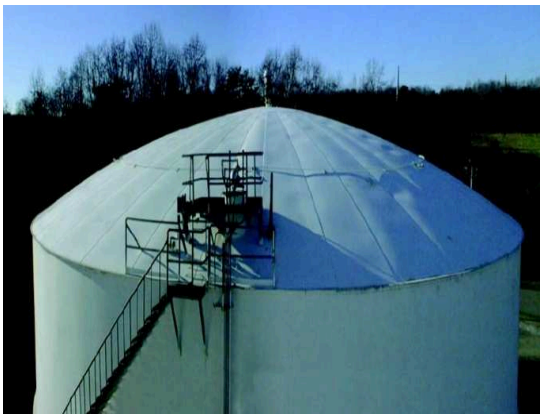
Figura 2.7 Tanque con techo tipo paraguas
