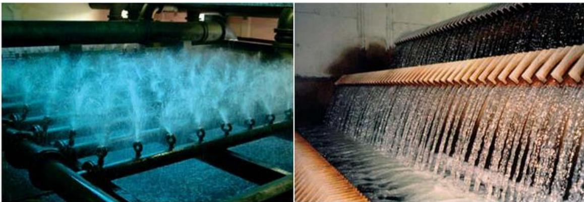
**Figura 1.7.** Sistemas de aireación con atomizadores tipo Amsterdam y cascada con distribuidores de flujo Jet
