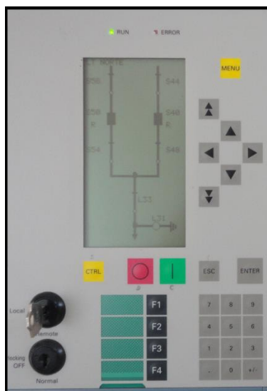
Figura 3. 13.- Diagrama Mímico del IED 67 de la S/E Selva Alegre.
