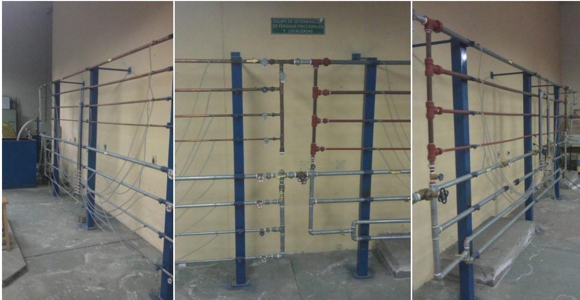
Figura 3.5. Equipo de prácticas para el estudio de pérdidas friccionales y localizadas
