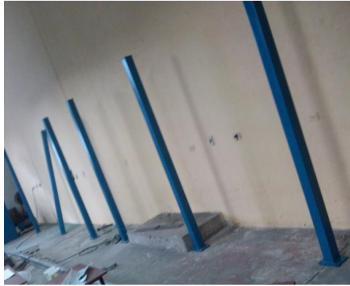
Figura 2.3. Cimentación de perfiles de soporte del equipo de determinación de pérdidas friccionales y localizadas
