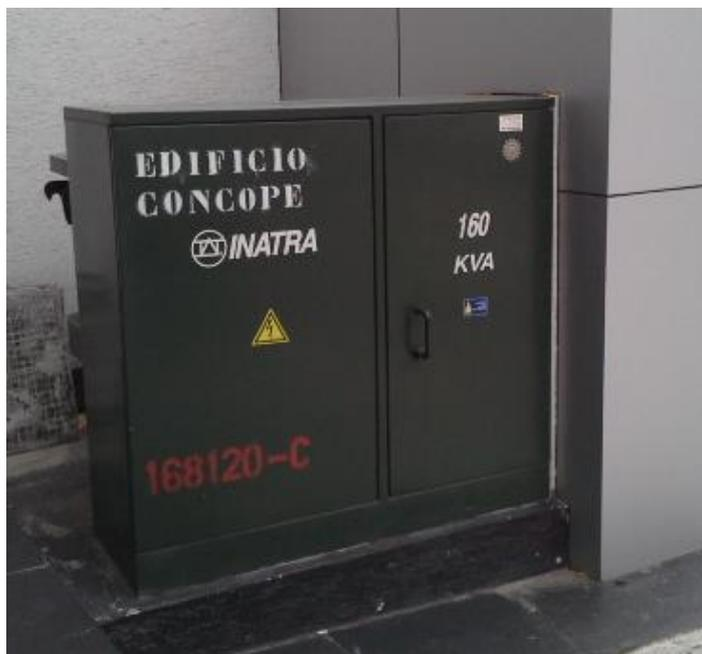
Fig. 1.1 Transformador tipo pedestal de la EEQ S.A.
