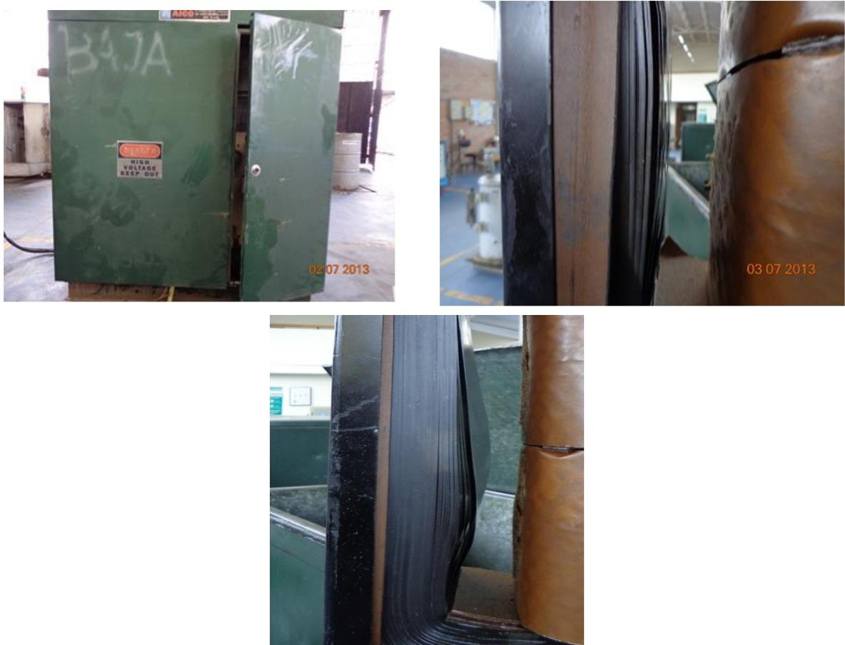
Fig. 4.10 Trasformador averiado AICO
