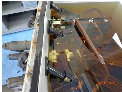
Fig. 4.11 Transformador averiado RYMEL
