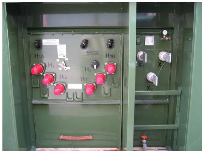
Fig. 1.9 Transformador Tipo Pedestal
