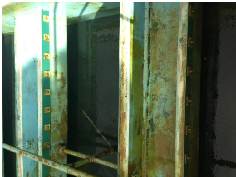
Fotografía: 2-1 Sistema de Lavado de celdas de filtro Puengasí.
