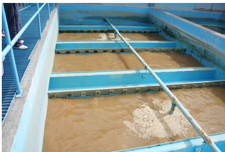
Fotografía: 2-2 Proceso de Lavado de celdas de filtro Puengasí
