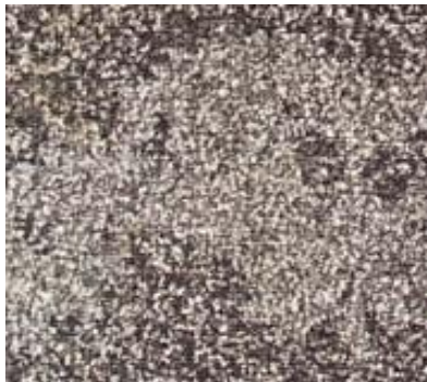
Figura 1. 8: Grado “B” preparada con un nivel de preparación de superficie equivalente a SA 2
