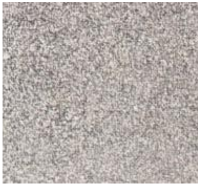
Figura 1. 15: Grado “C” preparada con un nivel de preparación de superficie equivalente a SA 3
