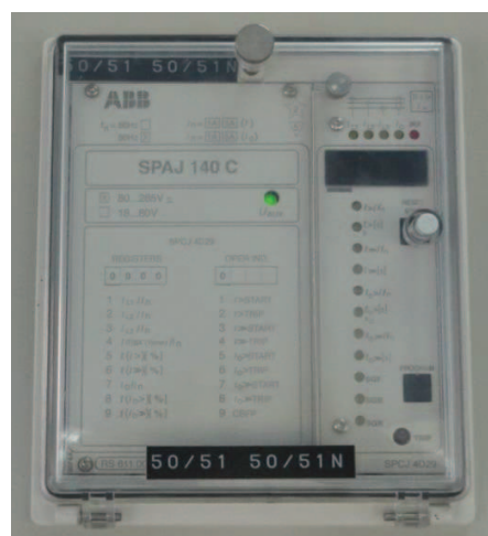
Figura 1.34. Relé SPAJ 140C en la subestación Cayambe
