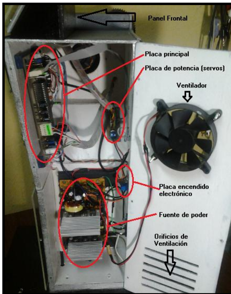
Figura 4.4 Ubicación de placas en la estructura soporte
