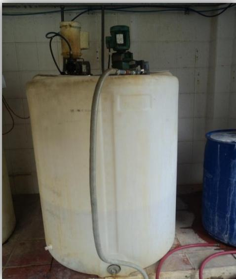
Figura: 1.4 tanque de Policloruro de Aluminio
