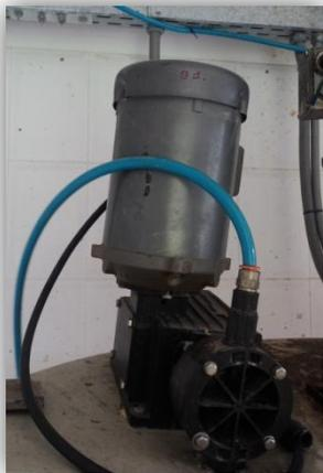
Figura: 1.7 Bomba dosificadora da ayudante de coagulación
