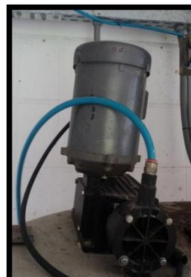
Figura: 8. Bomba dosificadora da ayudante de coagulación
