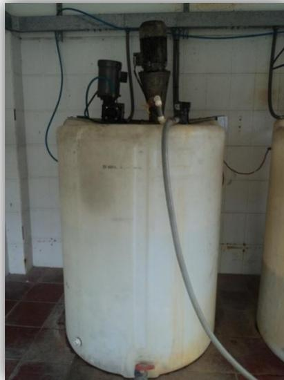
Figura: 1.3 tanque de ayudante de coagulación
