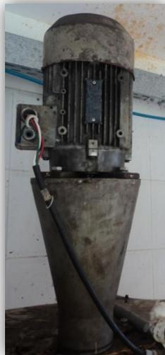
Figura: 1.9 Mezclador de ayudante de coagulación
