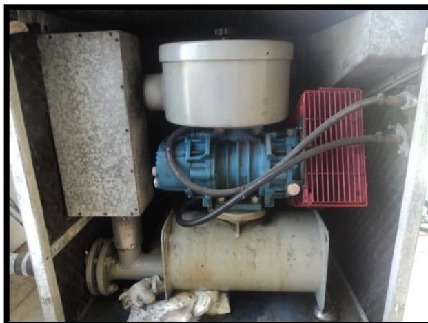
Figura 2. Compresor Robuschi Robox
