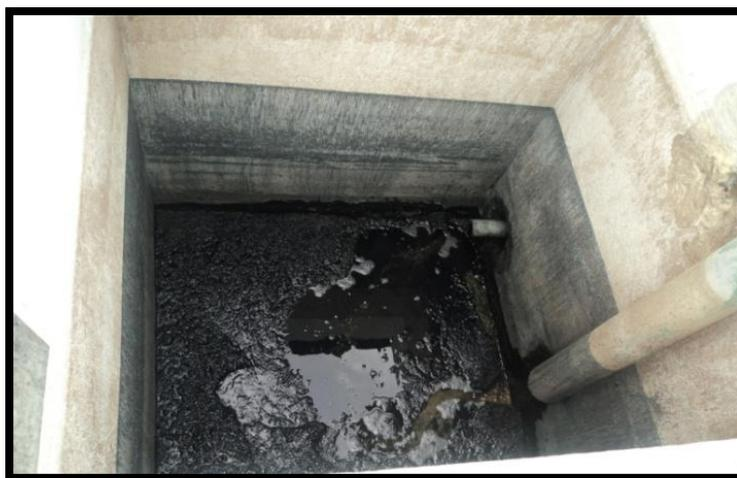
Figura: 12. Tanque de lodos
