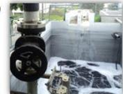
Manipular la válvula de compuerta según el caudal que se desea pasar:
