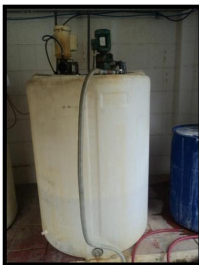
Figura: 5. Tanque de Policloruro de Aluminio
