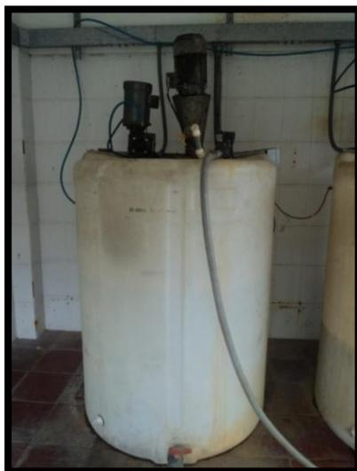
Figura: 4. Tanque de ayudante de coagulación
