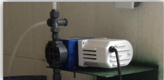
Figura: 1.8 Bomba dosificadora da ácido
