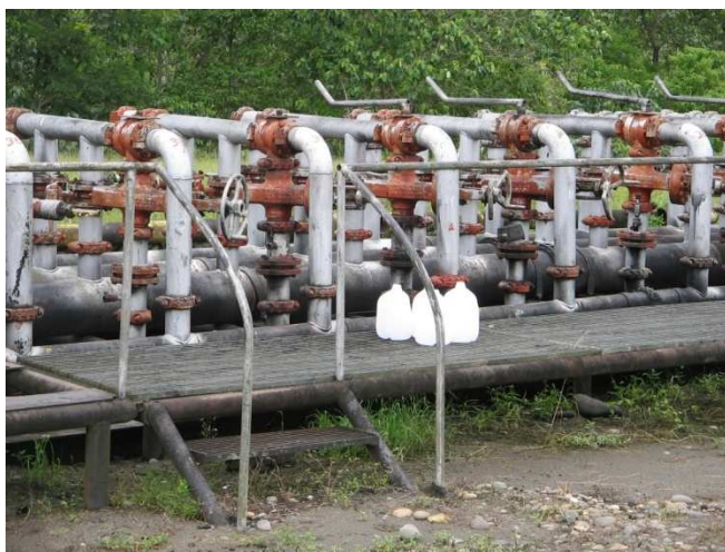
Figura 3.20: Manifold de la Estación de Producción Auca-Sur.
