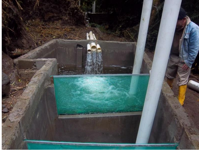
Gráfica 4.31 Desarenador existente en la obra
