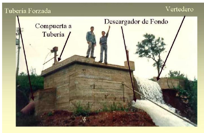
Gráfica 3.38 Exterior de la cámara de carga 34
