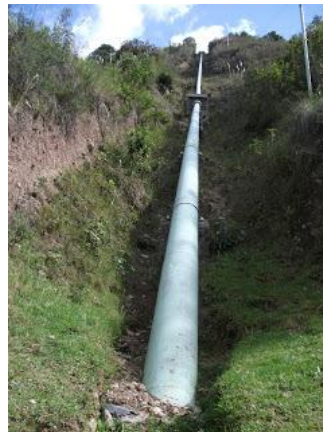
Gráfica 3.39 Tubería forzada
