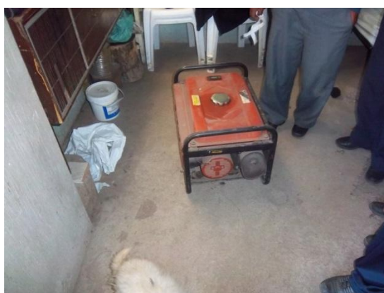
Gráfica 1.9 Generador que era empleado como fuente de energía.
