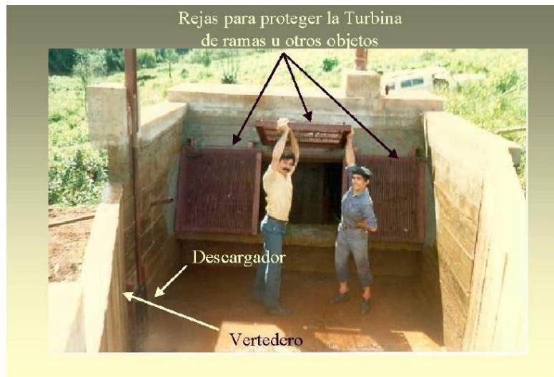
Gráfica 3.37 Interior de la cámara de carga
