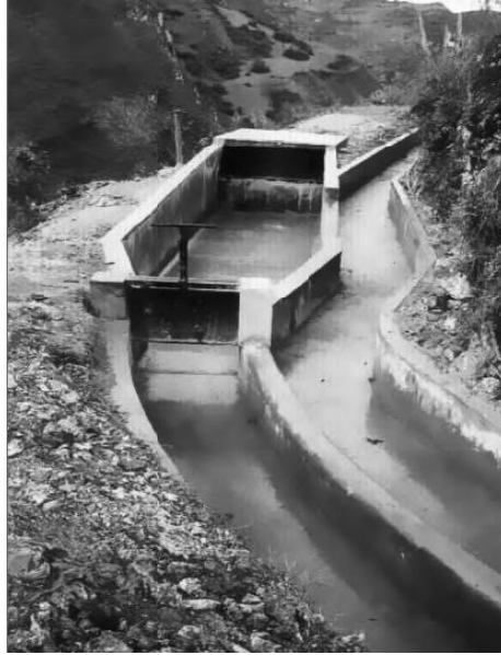
Gráfica 3.36 Desarenador a la entrada de la cámara
