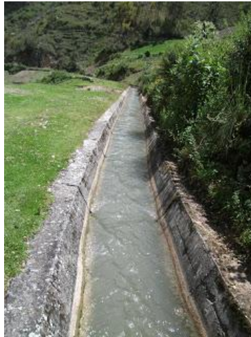
Gráfica 3.35 Canal revestido con concreto
