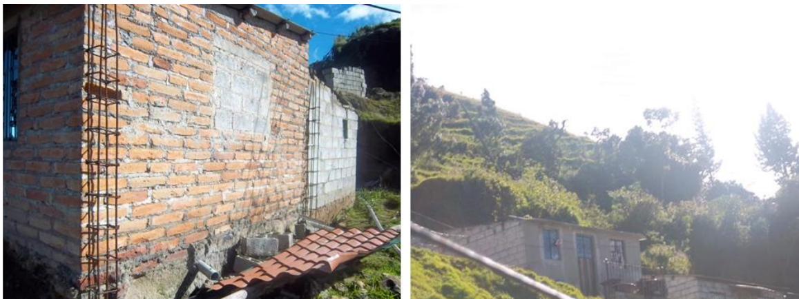
Gráfica 1.5 Vivienda de ladrillo (izquierda) y vivienda de bloque (derecha).
