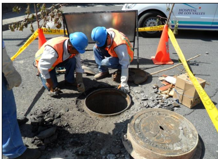
Figura 1.4. Fotografía que muestra a trabajadores de la EPMAPS realizando una reposición de tapa de alcantarillado
