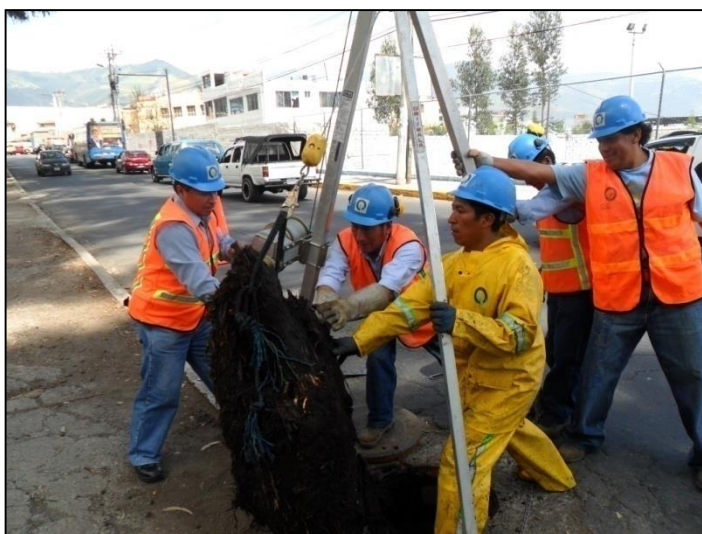
Figura 1.6. Fotografía que muestra la extracción manual de raíces con el uso de tecla
