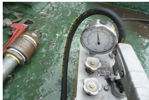
Figura 3.23. Bomba manual y banco de prueba con válvula instalada
