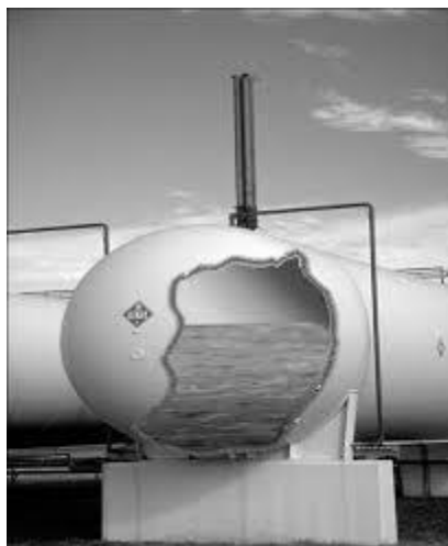
Figura 1.2. Almacenamiento de GLP en recipiente de presión
