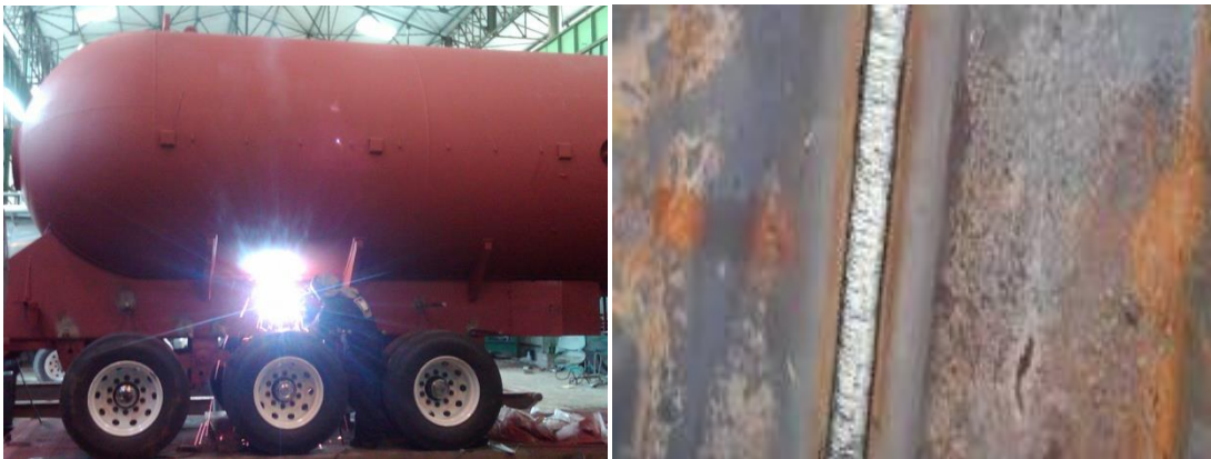
Figura 1.16. Soldadura en tanques de acero
