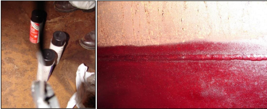
Figura 3.3. Aplicación del líquido penetrante
