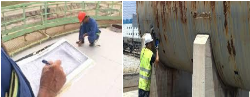
Figura 2.16. Inspección visual de recipientes para almacenamiento de combustible
