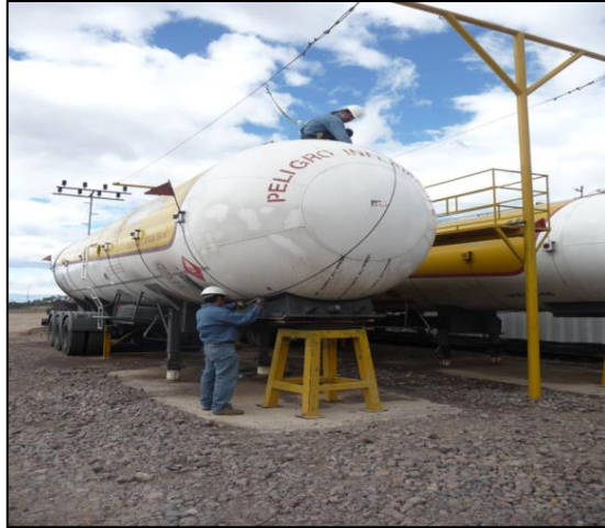
Figura 3.17. Toma de medida de la redondez de la cabeza del tanque
