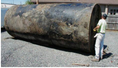
Figura 2.1. Tanque con corrosión
