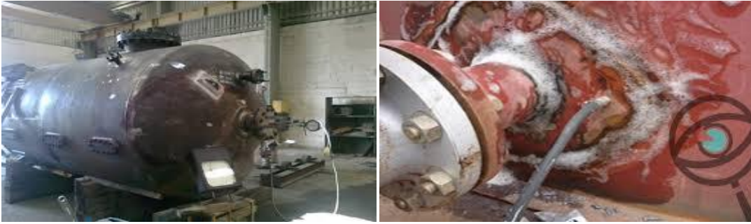
Figura 2.15. Inspección de fugas por prueba hidrostática
