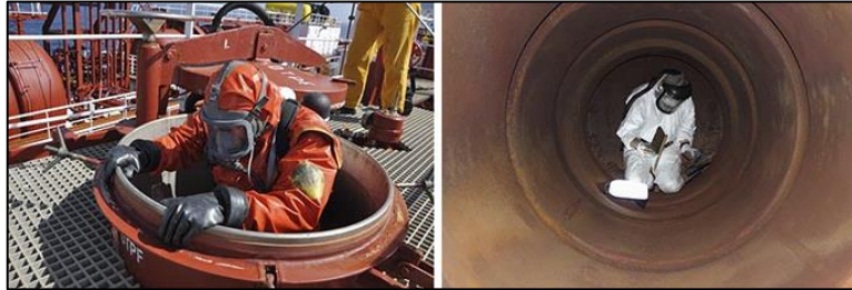
Figura 2.18. Trabajo en espacio confinado
