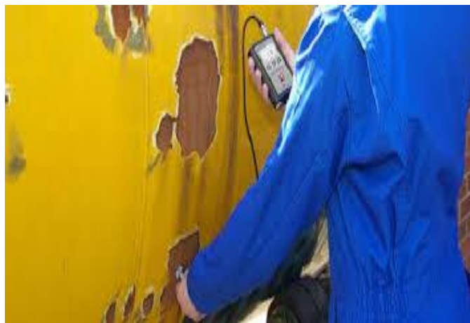
Figura 2.8. Medición de espesores de una lámina de acero
