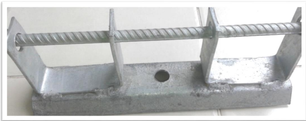
Figura 5.13: Bastidor de 2 vías.
